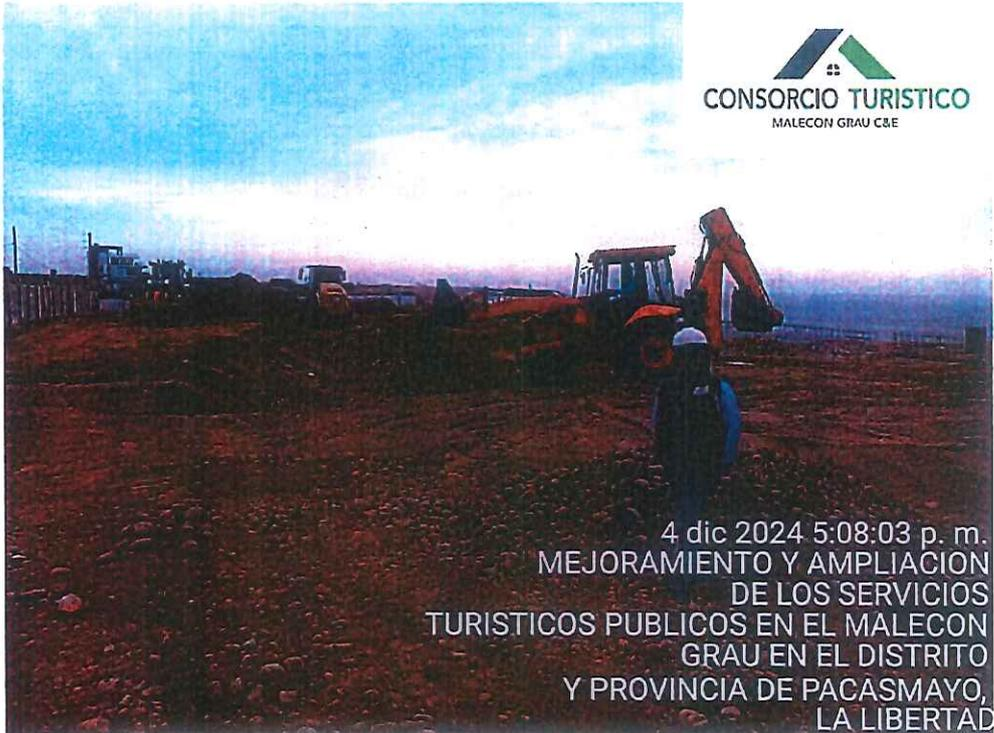
Imagen 3: Trabajos de movimiento de tierras relleno c/maquinaria
