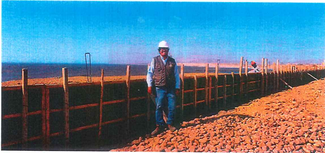
Imagen 1: Trabajos de encofrado
