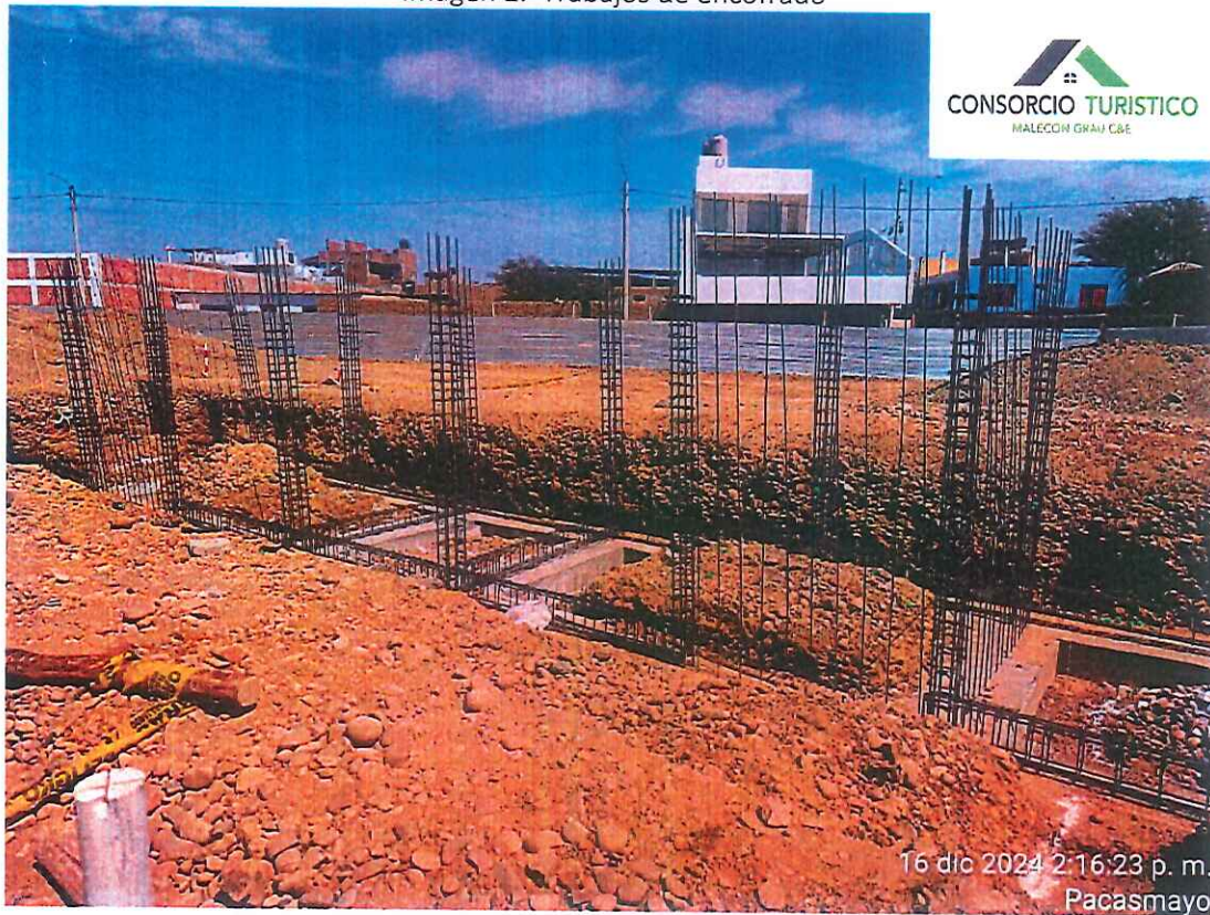
Imagen 2: Trabajos de habilitación e instalación de acero
