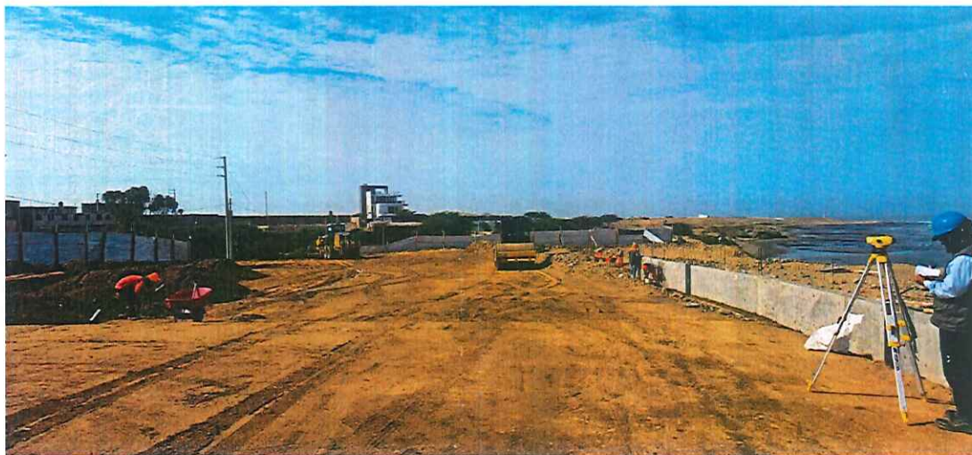
Imagen 2: Trabajos de conformación de sub rasante c/maquinaria
