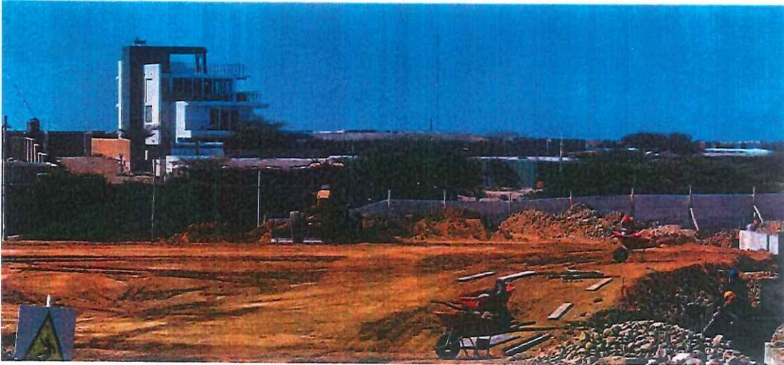
Imagen 1: Trabajos de conformación de sub rasante c/maquinaria
