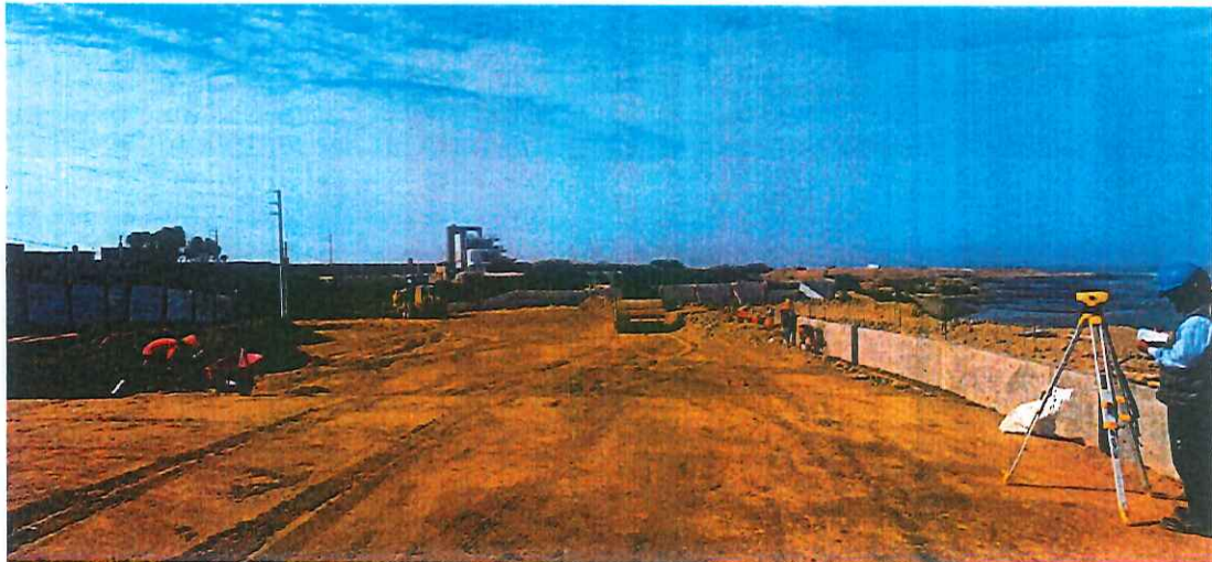
Imagen 2: Trabajos de conformación de sub rasante c/maquinaria
