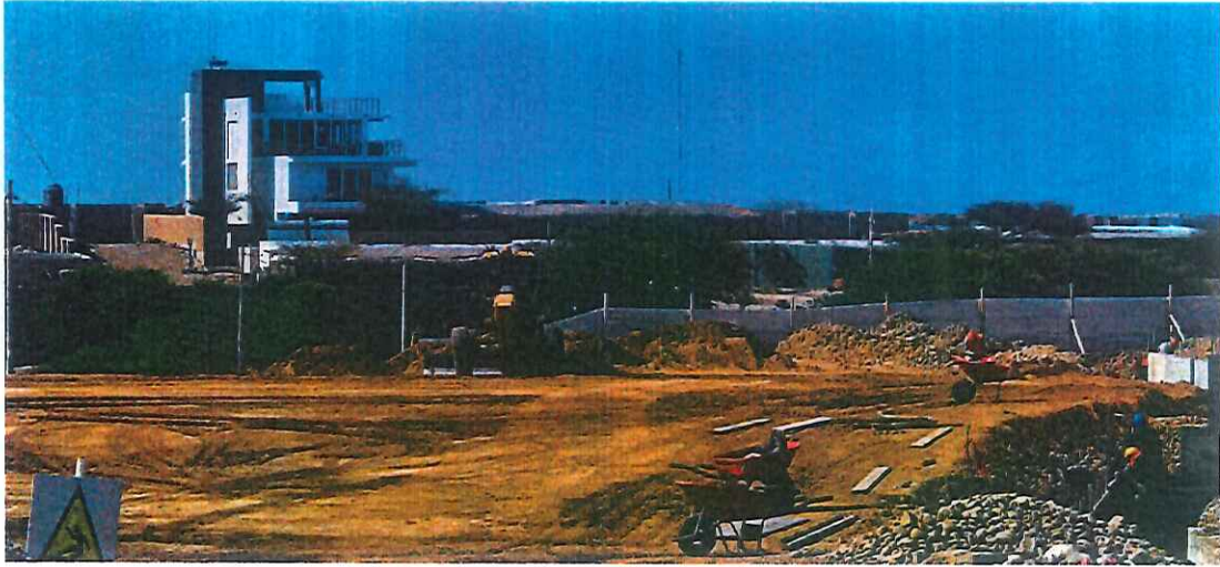
Imagen 1: Trabajos de conformación de sub rasante c/maquinaria
