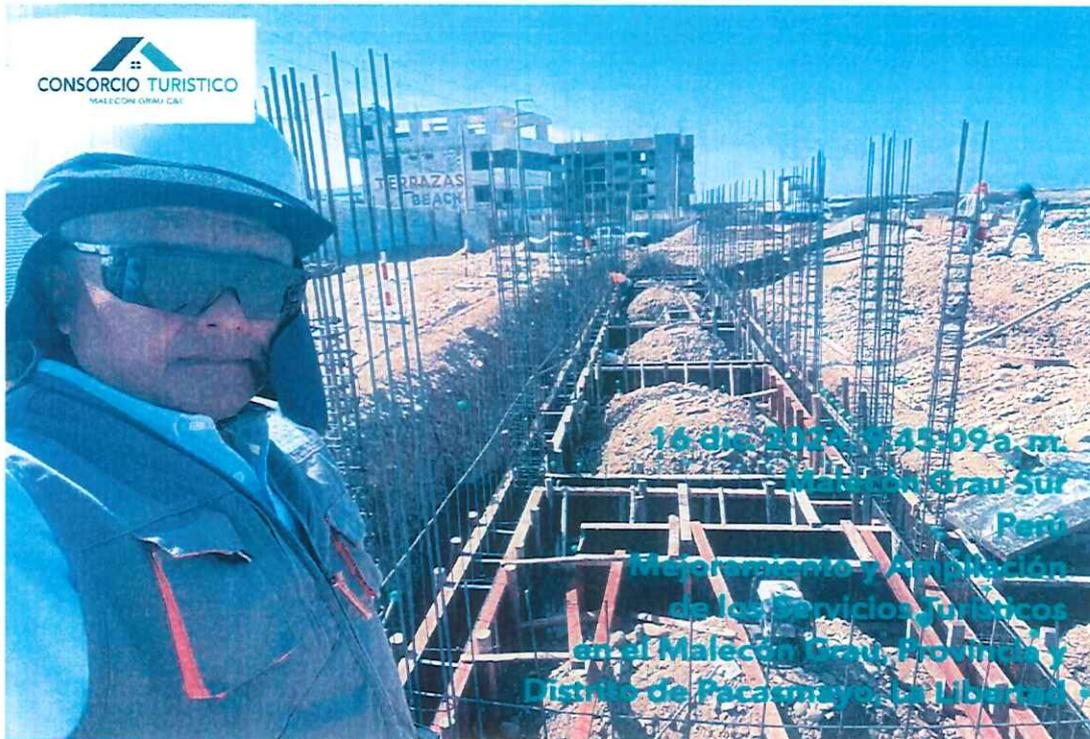
Foto 02: Se verifica los trabajos de encofrado de los sobrecimientos en el módulo 03
