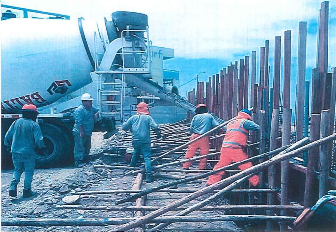
Foto 07: En la vista se aprecia los trabajos de vaciado de concreto  $f'c = 280 \text{ kg/cm}^2$  en sobre cimiento en el módulo 02, se tomaron las muestras de concreto vaciado.
