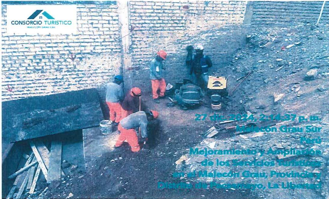
Foto 09: En la vista se aprecia los trabajos de los ensayos de densidad de campo supervisado por el especialista de calidad de la supervisión en la escalera 20, previo al vaciado del solado.
