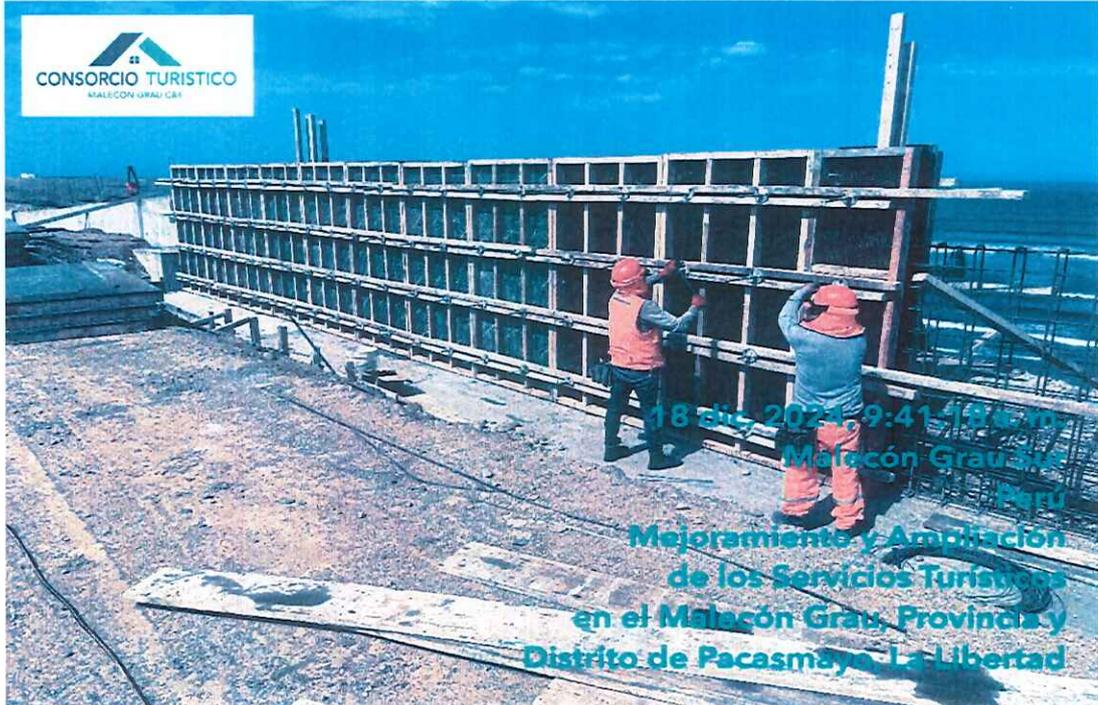
Foto 05: En la vista se aprecia los trabajos de encofrado de la pantalla muro MC 2A..
