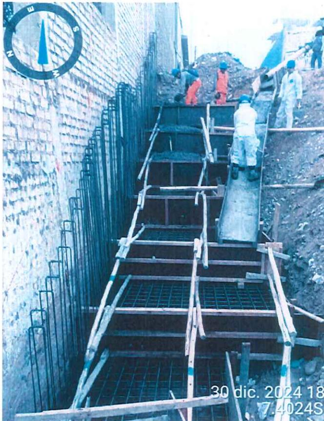
Foto 10: En la vista se aprecia los trabajos de vaciado de concreto  $f'c=310$  kg/cm<sup>2</sup> en la escalera 20 de la obra.
