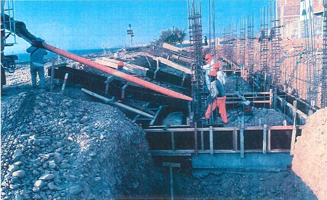
Foto 03: Se verifica los trabajos de vaciado de las vigas de cimentación en el módulo 03
