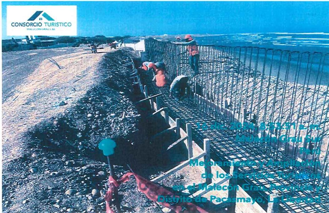
Foto 01: Se verifica los trabajos de habilitación y colocación de la armadura en el muro MC -2A
