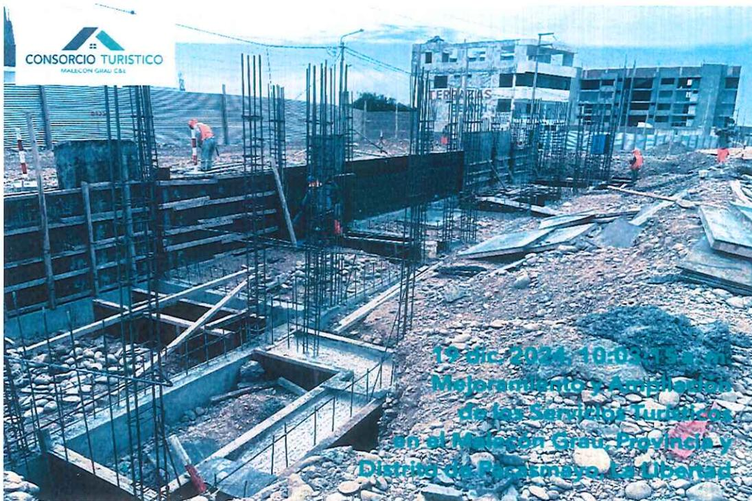
Foto 06: En la vista se aprecia los trabajos de encofrado de los sobrecimientos en módulo 03.
