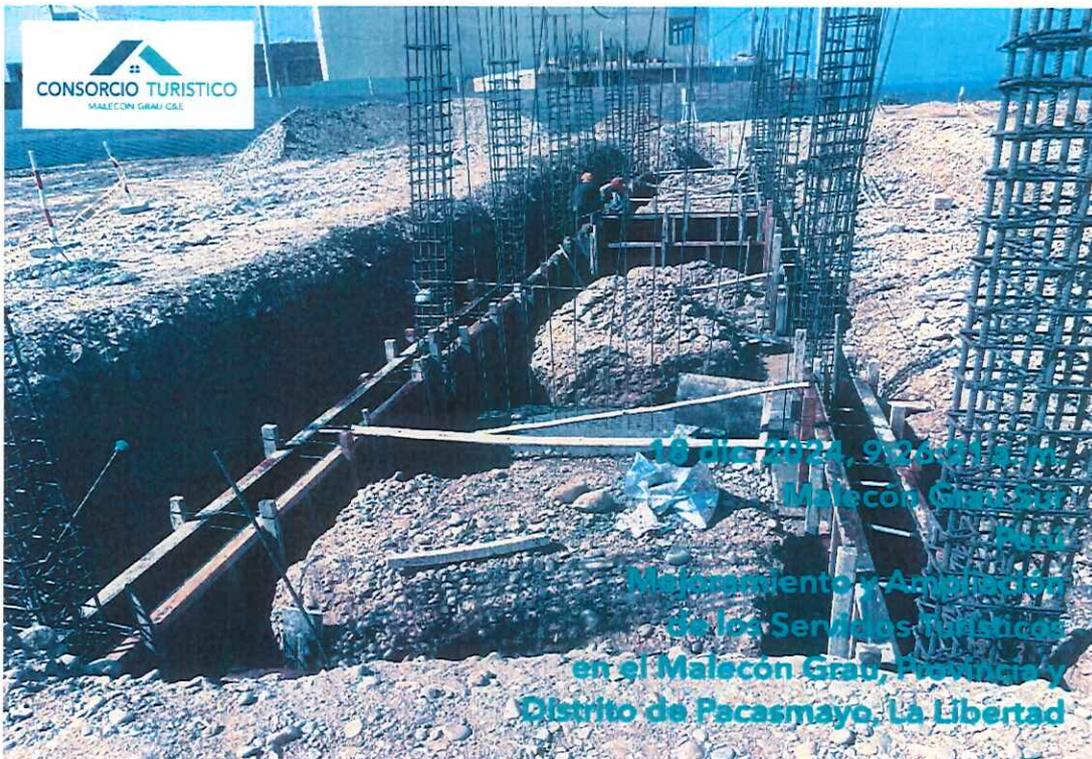
Foto 04: En la vista se aprecian los trabajos de encofrado de sobre cimientos armados en el área de módulo 02.
