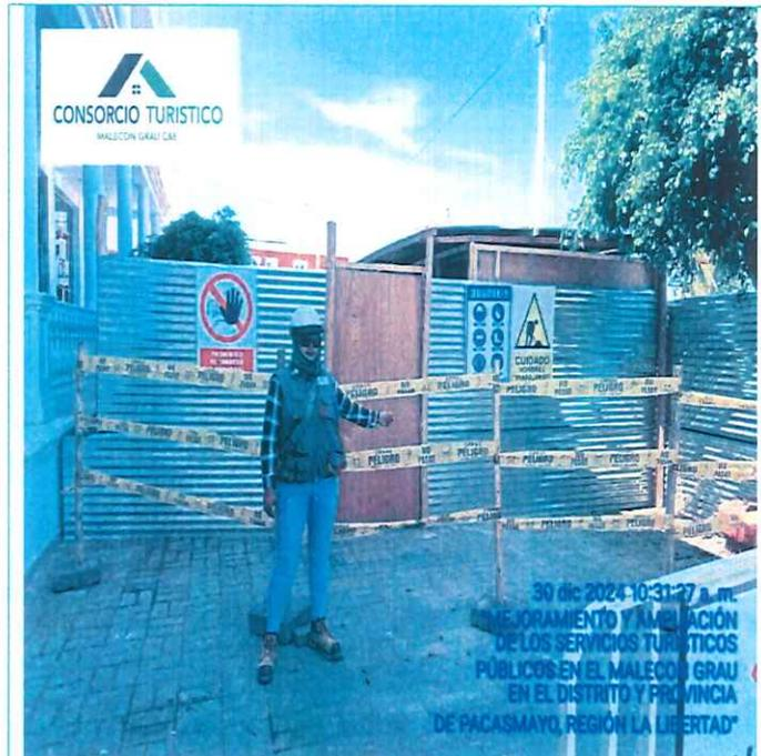
**Imagen N°6: Malla de seguridad, cinta color amarillo y cachacos de concreto.**
