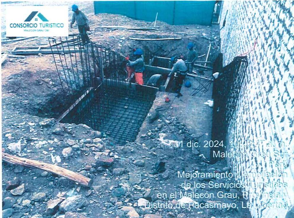
*Foto 5: Se verificó que realicen una correcta colocación y habilitación de acero de muros de contención en la zona de escaleras, ya que posterior a ello se realizará el anclado para las barandas de madera..*
