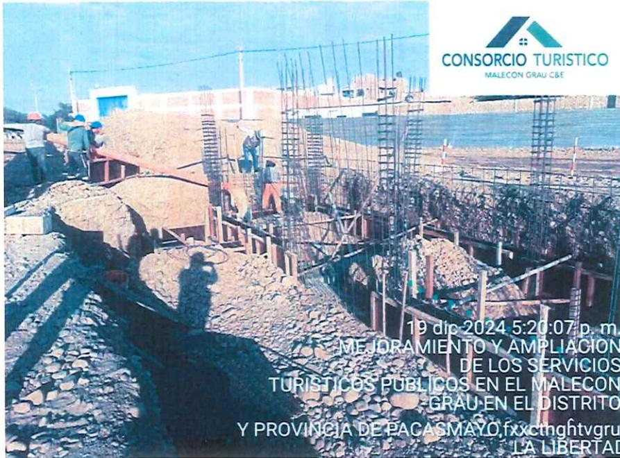
Foto 3: Vaciado de concreto en los Sobrecimientos de los módulos 02 y 03.
