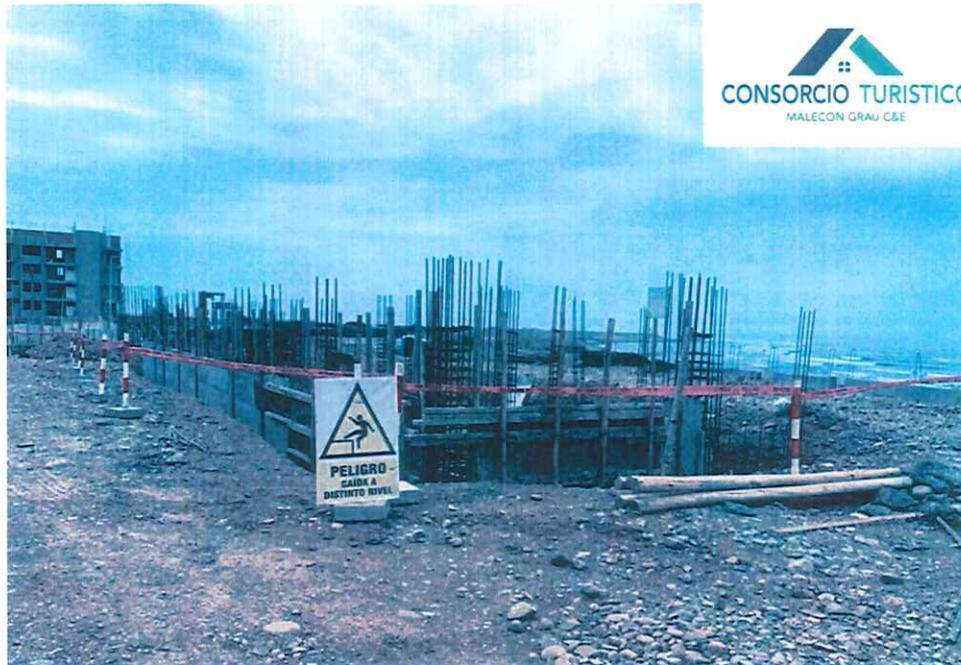
Foto 4: Desencofrado de sobrecimiento, y listo para el asentado de ladrillo.
