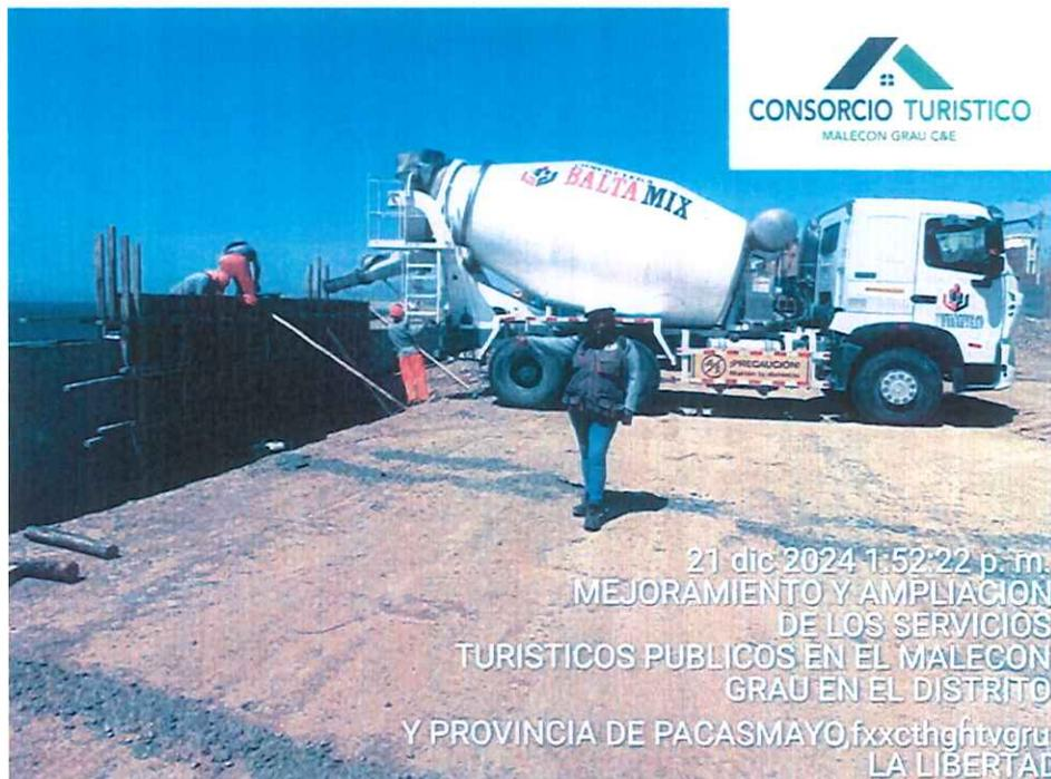
*Imagen 04: Se realizó el vaciado en muros cde contención del Malecón Sur.*
