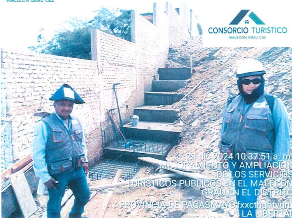
*Imagen 05: Se verificó la correcta habilitación de acero en escaleras..*
