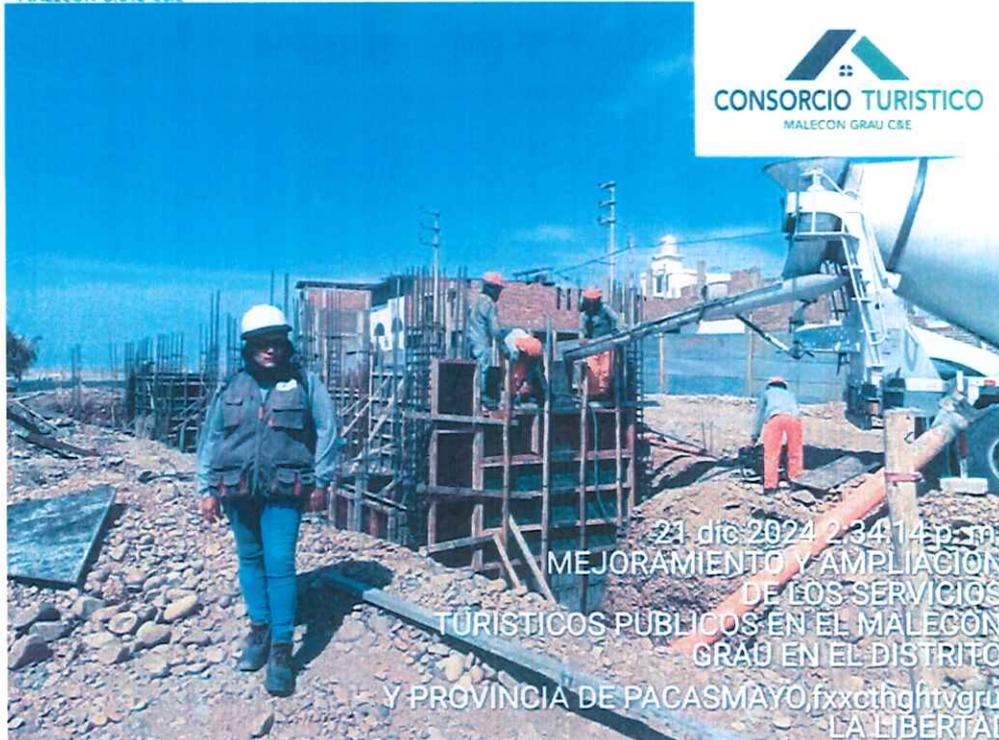
*Imagen 03: Se realizó el vaciado correspondiente a los sobrecimiento de ambos módulos.*
