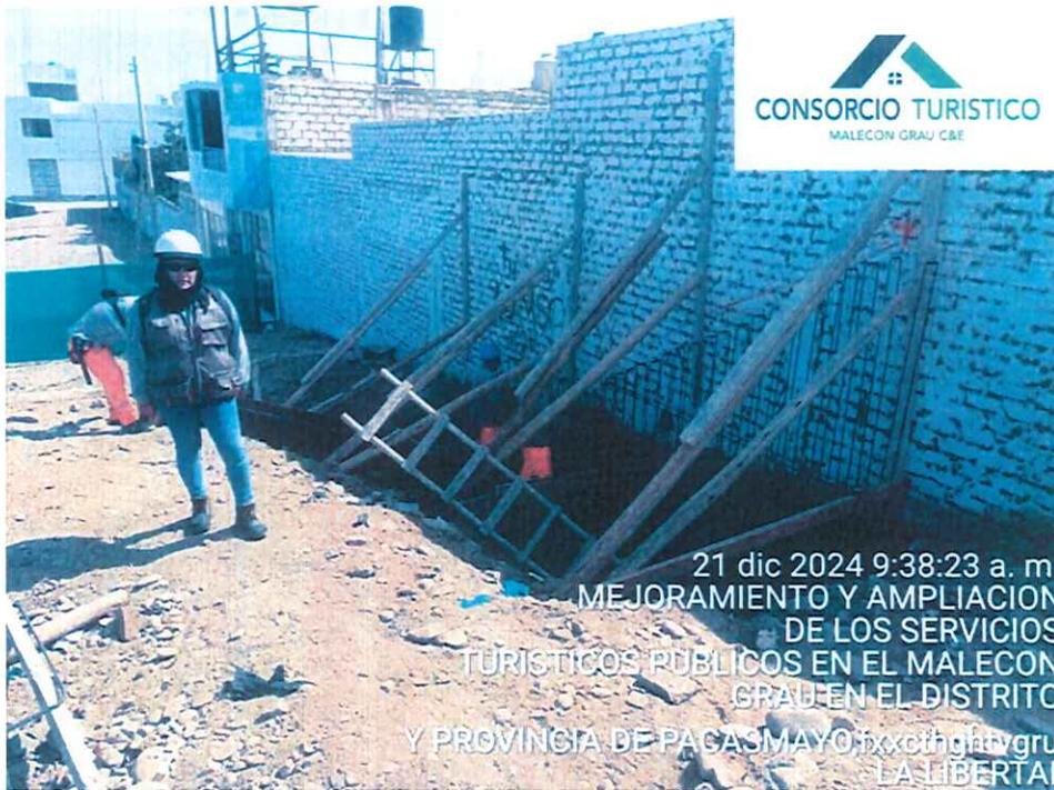
*Imagen 06: Se realizó la habilitación de acero para los muros de contención de la escalera.*
