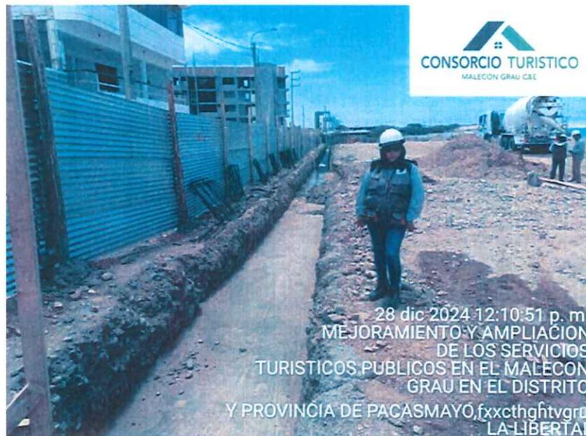
*Imagen 02: Se verificó la correcta compactación del canal lateral, para empezar con el vaciado del solado..*
