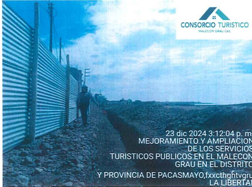
*Imagen 01: Se realizó la excavación de la cuneta lateral en el tramo 6 correspondiente al Malecón Sur..*
