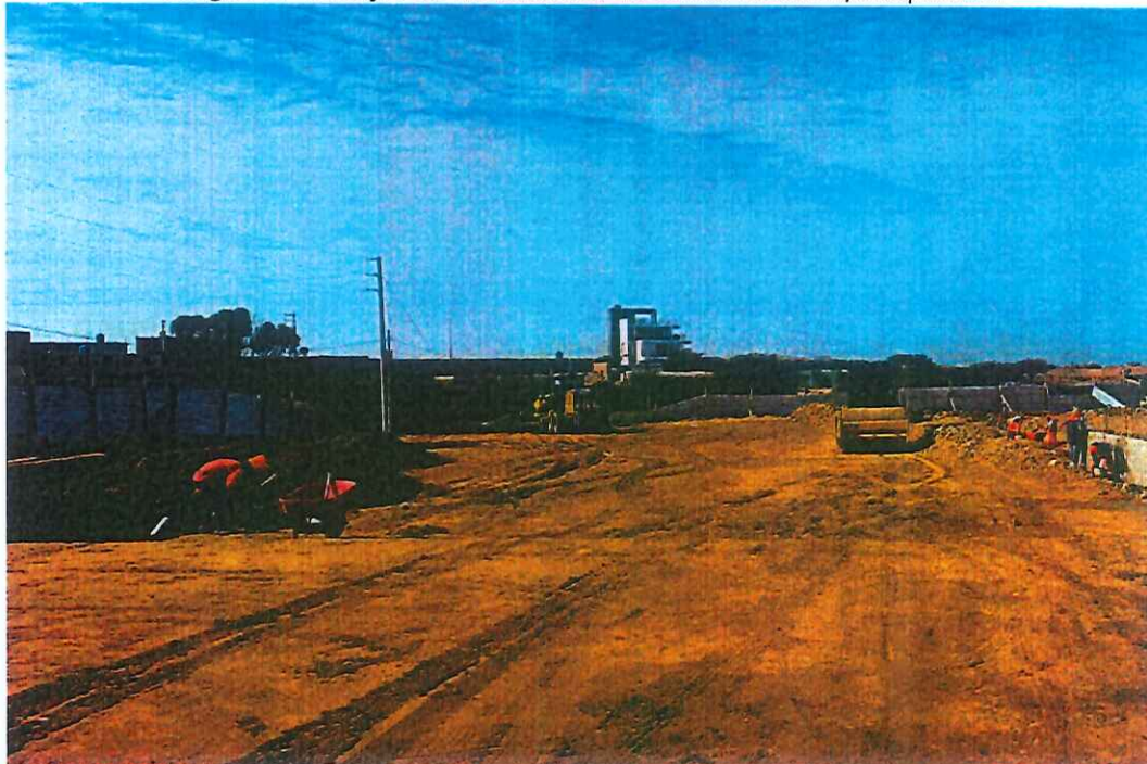
Imagen 2: Trabajos de movimiento de tierras relleno c/maquinaria
