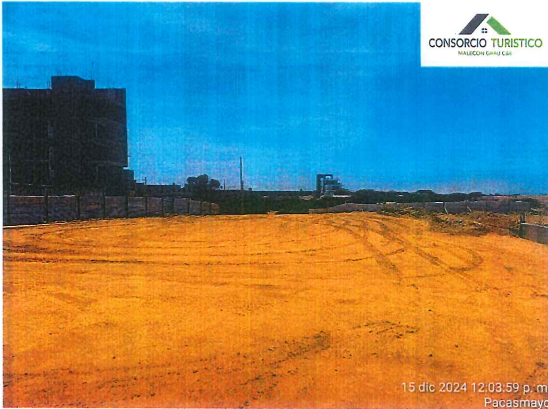
Imagen 1: Trabajos de movimiento de tierras relleno c/maquinaria
