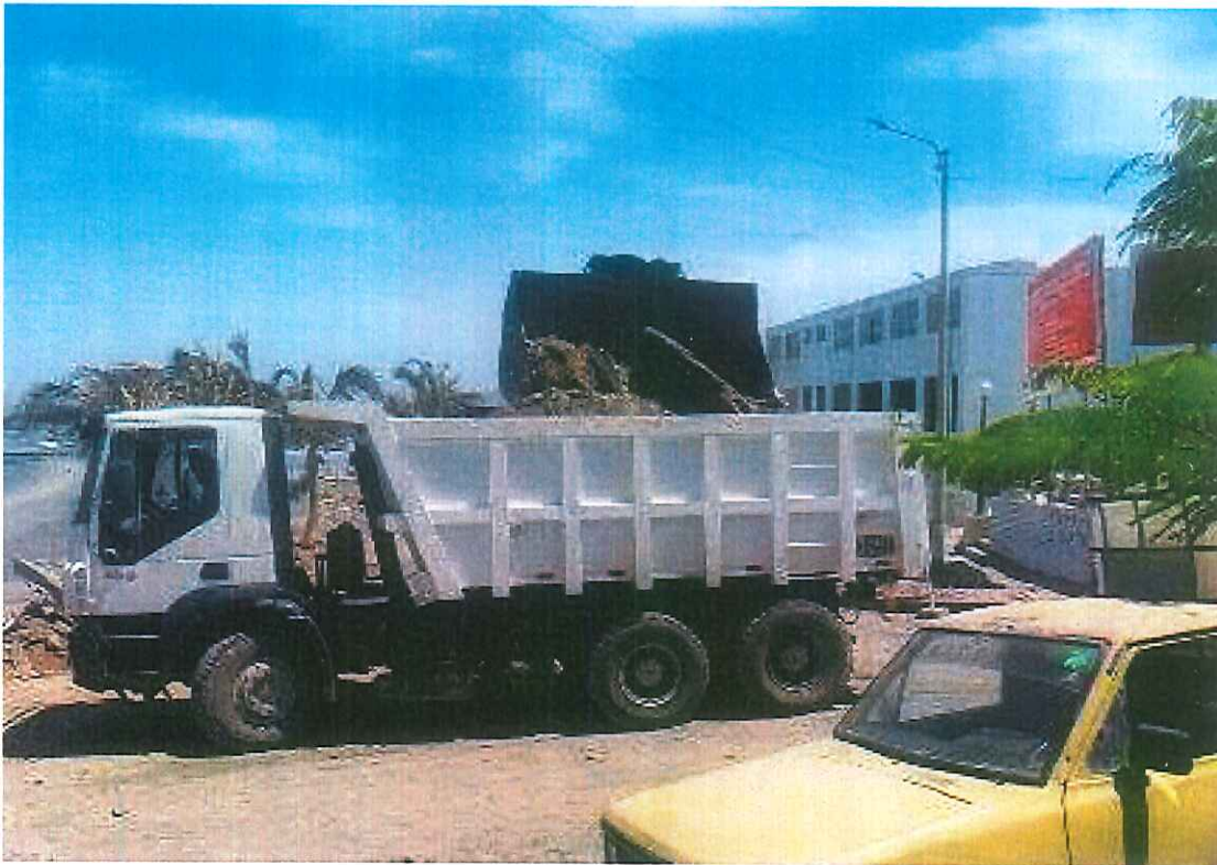
Imagen 2: Trabajos de movimiento de tierras c/maquinaria
