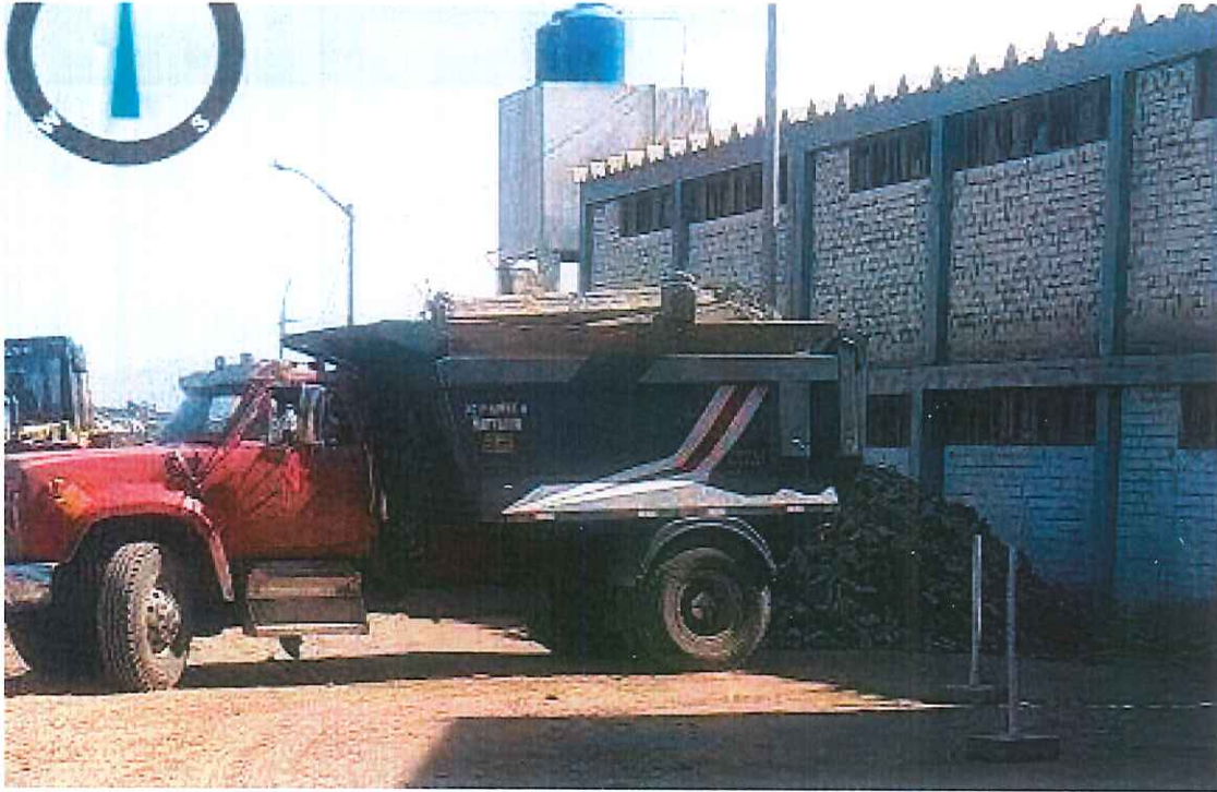
Imagen 1: Trabajos de movimiento de tierras c/maquinaria
