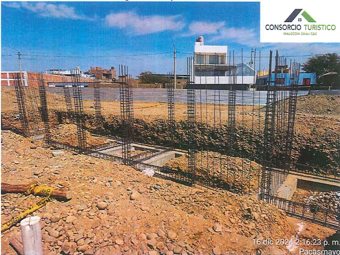
Imagen 2: Trabajos de habilitación e instalación de acero
