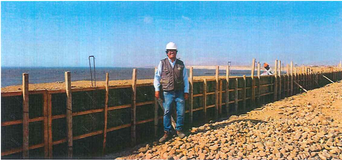
Imagen 1: Trabajos de encofrado
