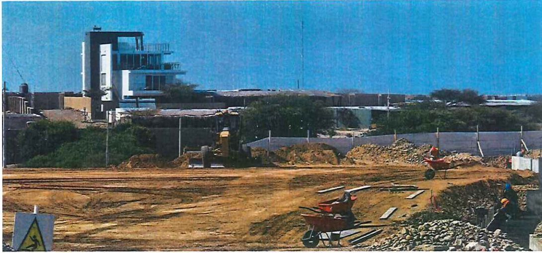
Imagen 1: Trabajos de conformación de sub rasante c/maquinaria
