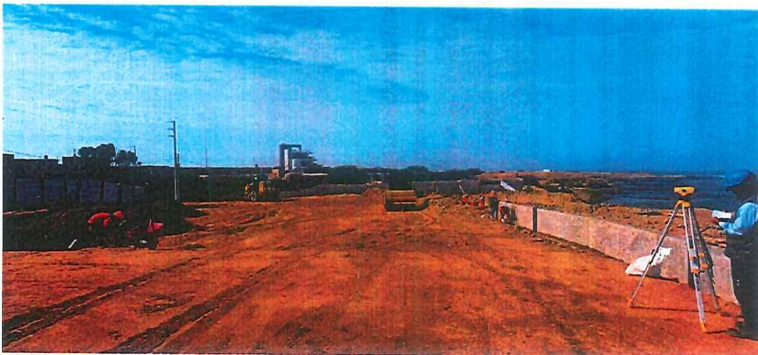
Imagen 2: Trabajos de conformación de sub rasante c/maquinaria
