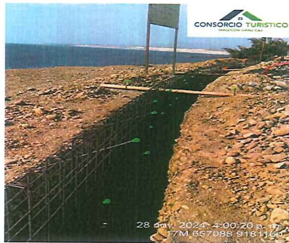
Fotografía 8: Implementación de capuchones en acero expuesto.
