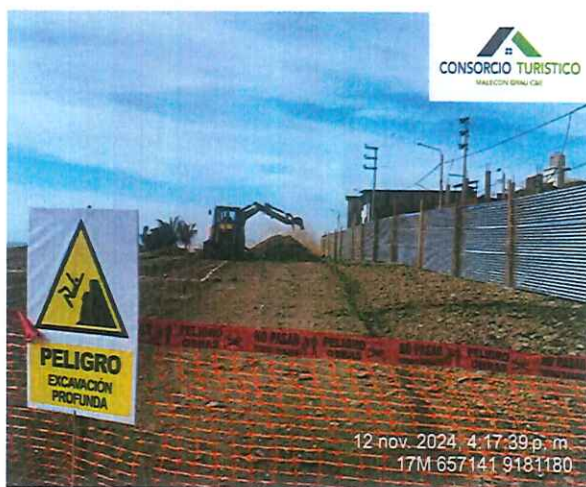
Fotografía 6: Delimitación y señalización de áreas de trabajo.
