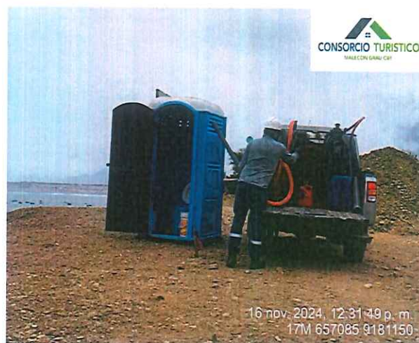
Fotografía 9: Limpieza de baños químicos.
