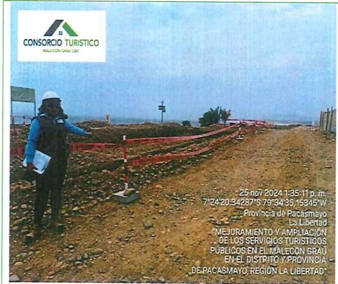
**Imagen N°06: Se llevan acabo la instalación de cachacos con cinta de seguridad al costado de zanja.**
