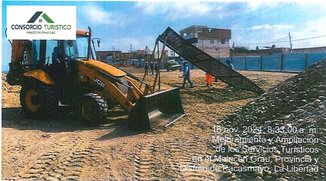
**Foto 03:** En la vista se aprecia el inicio de los trabajos de zarandeo de material de corte para ser utilizado en los rellenos con material propio seleccionado.
