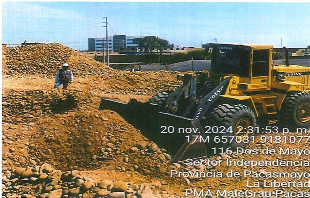
**Foto 05:** En la vista se aprecia a especialista de estructuras de la contratista realizando los trabajos de zarandeado del material propio afin de ser utilizado en los rellenos considerados en obra.
