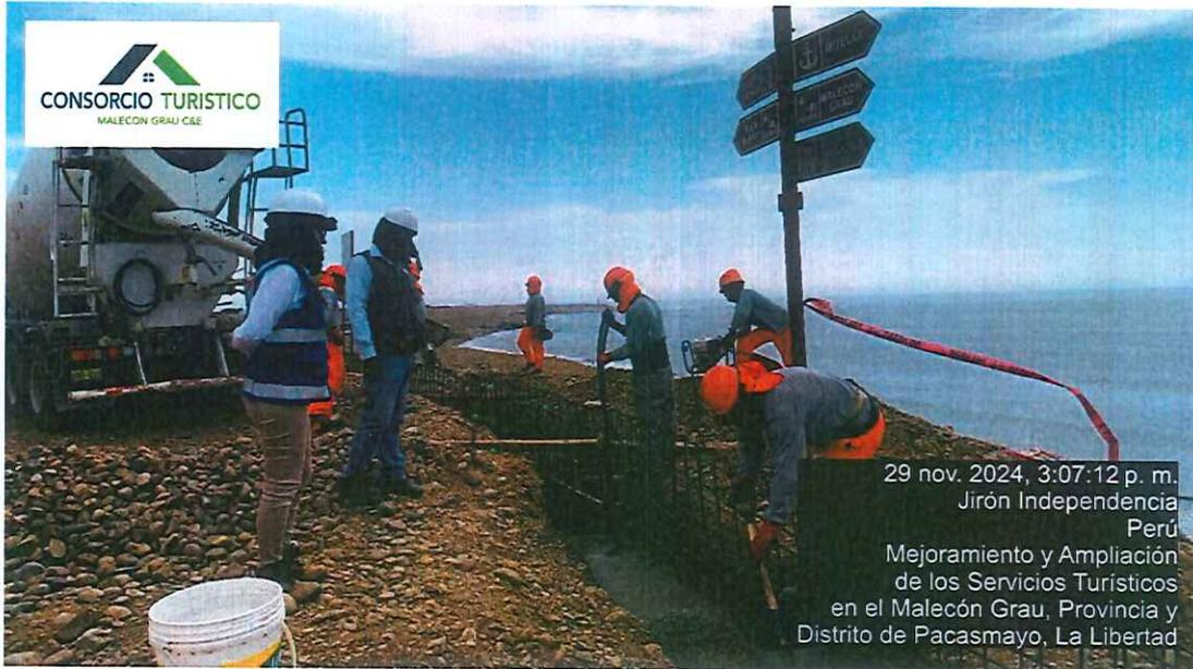
**Foto 09:** En la vista se aprecia al especialista de estructuras con especialistas de la supervisión verificando el vaciado de concreto en la cimentación con concreto  $f_c=210\text{kg/cm}^2$  en los muros de sobrecimientos armados.
