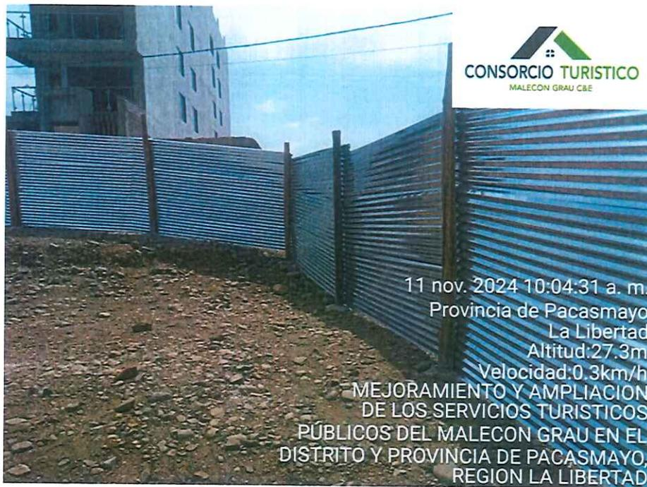
Foto 4: culminación de cerco provisional, con palos de madera y calamina
