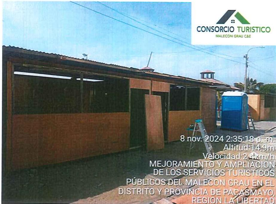
Foto 2: Instalación de casetas de madera provisional
