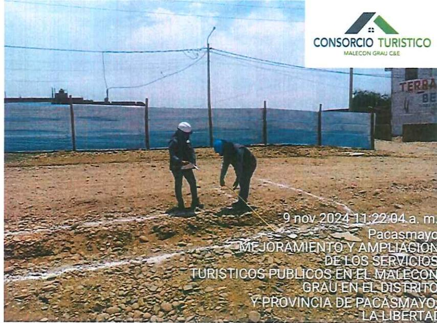
*Imagen 01: Se realizó el trazo de los módulos 02 y 03, en esta imagen se observa el trazo del módulo 03, para su posterior excavación.*
