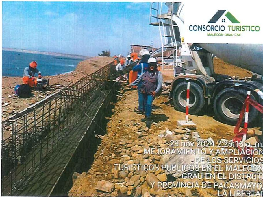
*Imagen 06: Se realizó el vaciado para Cimiento Corrido F'C=210 kg/cm<sup>2</sup> + 30% P.G. MÁX. 8" con presencia de la Supervisión y el personal Clave de la obra.*
