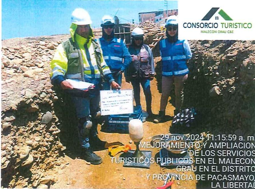
*Imagen 05: En campo se realizó los ensayos de densidad, con la presencia de la Supervisión.*
