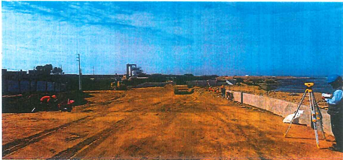
Imagen 2: Trabajos de conformación de sub rasante c/maquinaria
