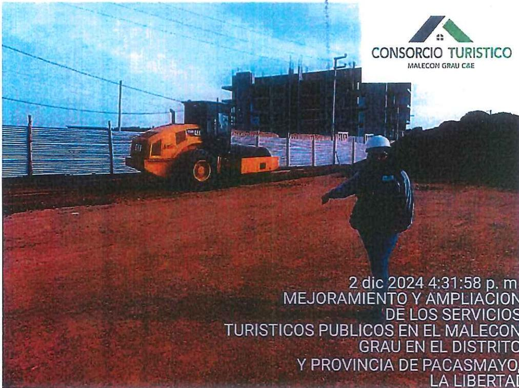
Imagen 1: Trabajos de movimiento de tierras relleno c/maquinaria
