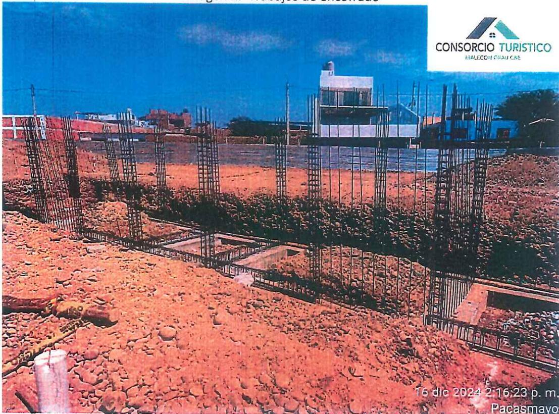
Imagen 2: Trabajos de habilitación e instalación de acero
