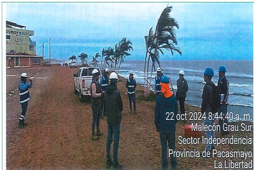
Imagen N°06: Se llevan a cabo las charlas de inicio de obra, llamadas también charlas de 5 minutos a todo el personal en obra.
