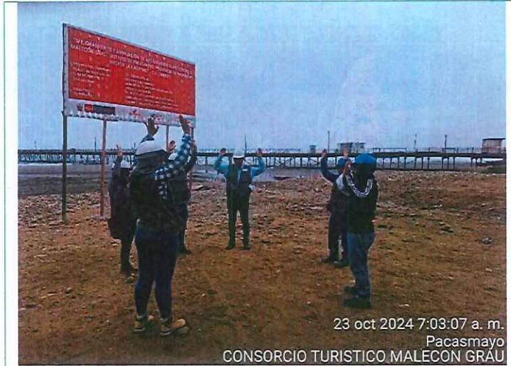
Imagen N°05: Se llevan a cabo las charlas de inicio de obra, llamadas también charlas de 5 minutos a todo el personal en obra.
