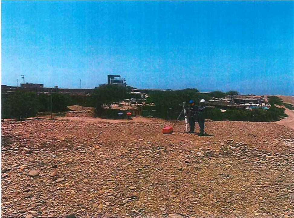
**Foto 01:** En coordinación con el topógrafo referente a los trabajos del Trazo y Replante en el tramo final de la obra.
