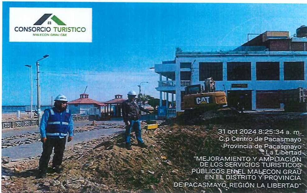
Foto 06: En la vista se aprecia al especialista de Estructuras del Consorcio Turístico Malecón Grau con el especialista de la supervisión verificando los trabajos de excavación masiva con maquinaria.
