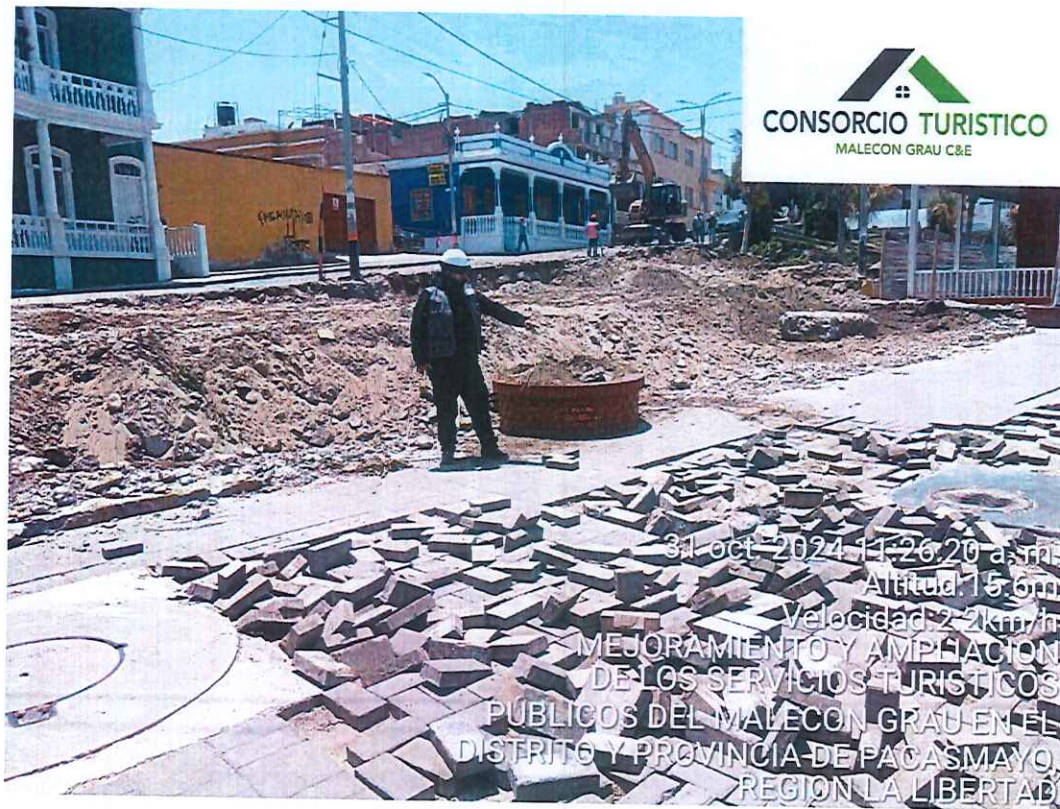
Foto 6: Demolición de pavimento de adoquín y eliminación
