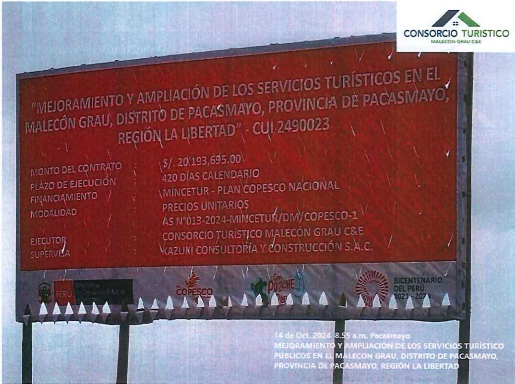
Foto 1: Instalación de Cartel de obra
