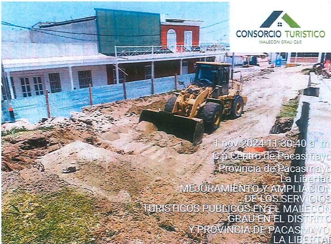
Imagen 6: Trabajos de movimiento de tierras c/maquinaria
