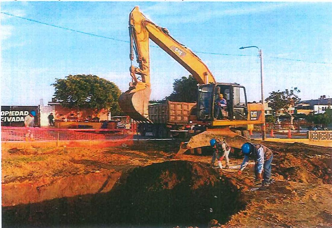
Imagen 2: Trabajos de movimiento de tierras c/maquinaria
