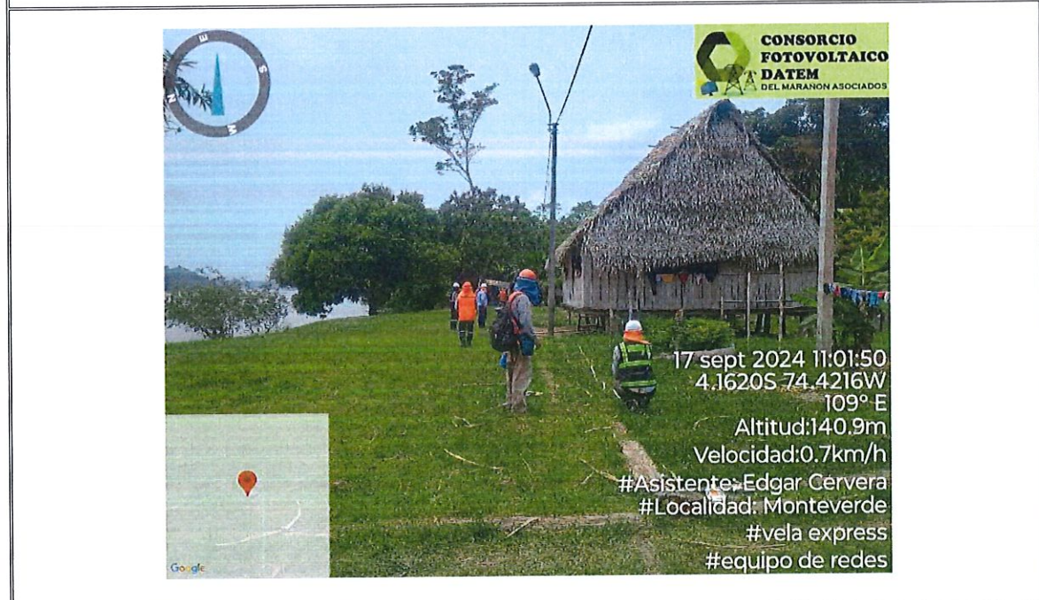
Foto 12. : Se muestra realizando el Replanteo Topográfico, Ubicación de Estructuras en Redes Secundarias, en la localidad de Monte Verde.
