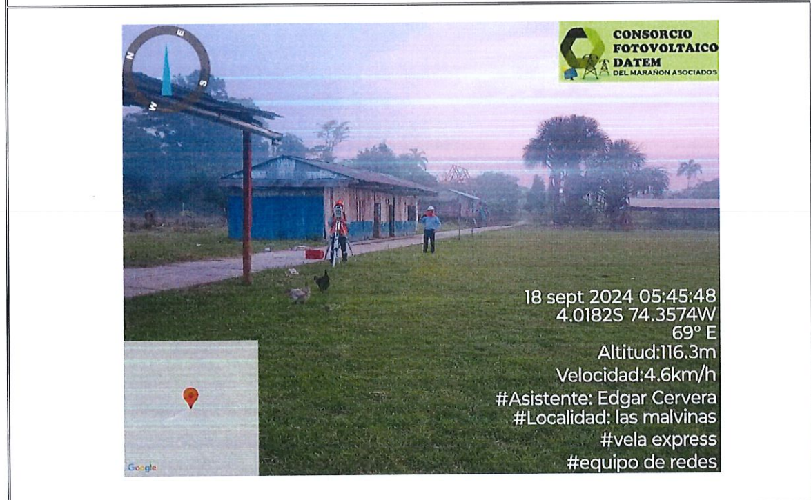
Foto 16. : Se muestra realizando el Replanteo Topográfico, Ubicación de Estructuras en Redes Secundarias, en la localidad de Malvinas.
