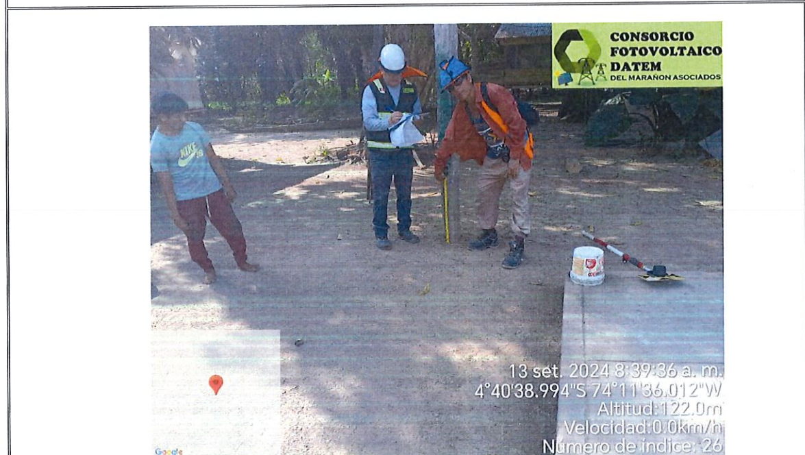
Foto 13. : Se muestra realizando el Replanteo Topográfico, Ubicación de Estructuras en Redes Secundarias, en la localidad de Bolívar.
