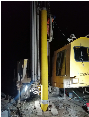
a) Instalación de tramo de la tubería filtro cubierto de filtro textil
