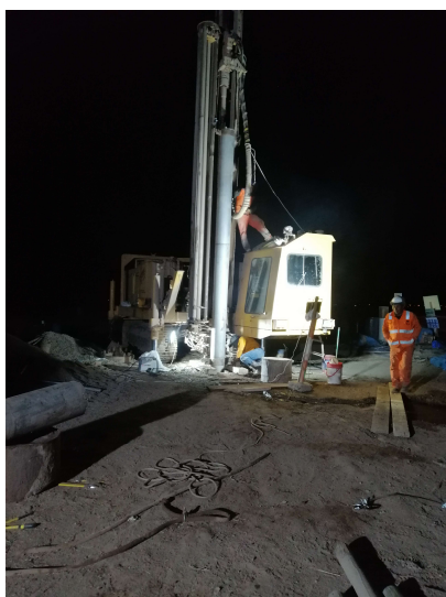
b) Instalación de tramo de tubería ciega
