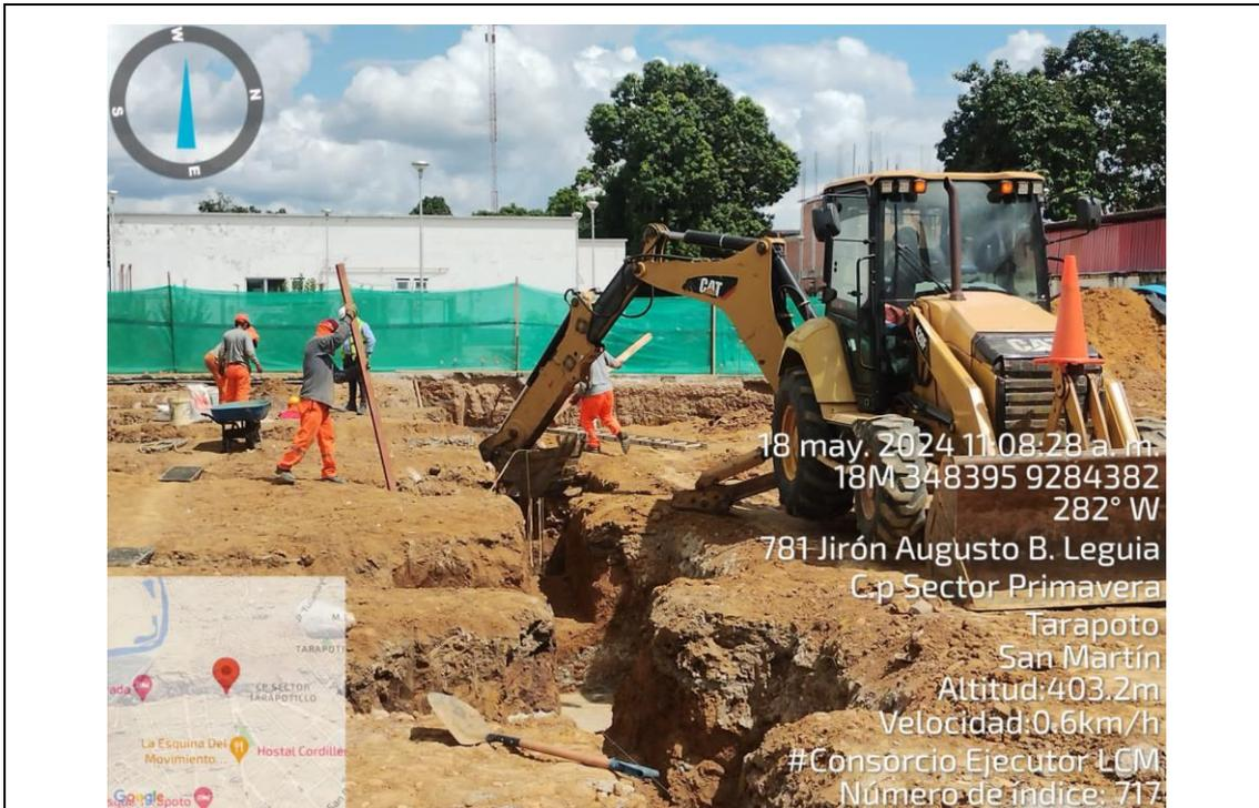
**Fotografía N° 13: EXCAVACION CON MAQUINARIA LAS VIGAS DE CIMENTACION**
