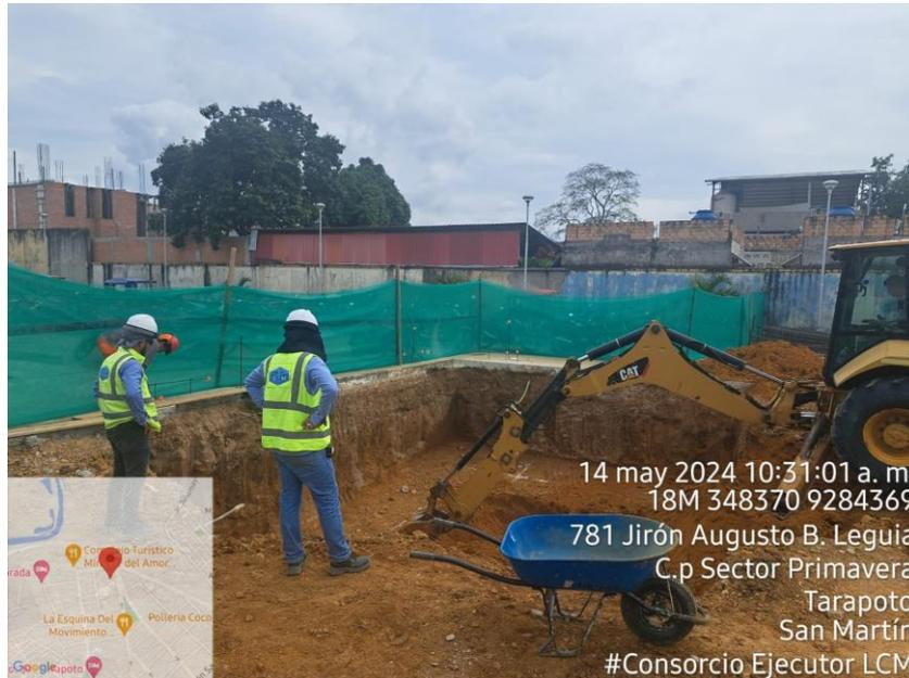
**Fotografía N° 06:** EXCAVACION CON MAQUINARIA AREA DE CISTERNA
