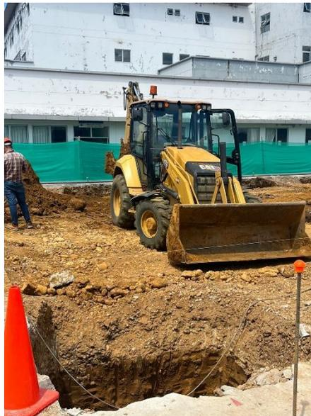
**Fotografía N° 04: EXCAVACION CON MAQUINARIA LAS ZANJAS DE ZAPATA**
