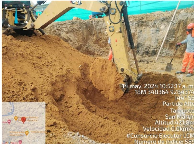
**Fotografía N° 08: EXCAVACION CON MAQUINARIA AREA DE CISTERNA**
