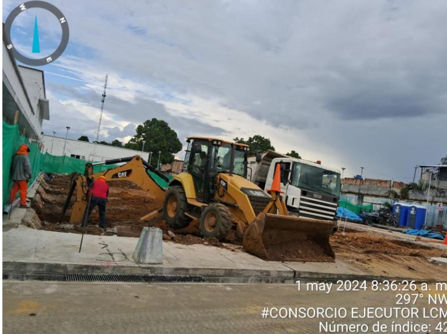
**Fotografía N° 01: EXCAVACION CON MAQUINARIA LAS ZANJAS DE ZAPATA**
