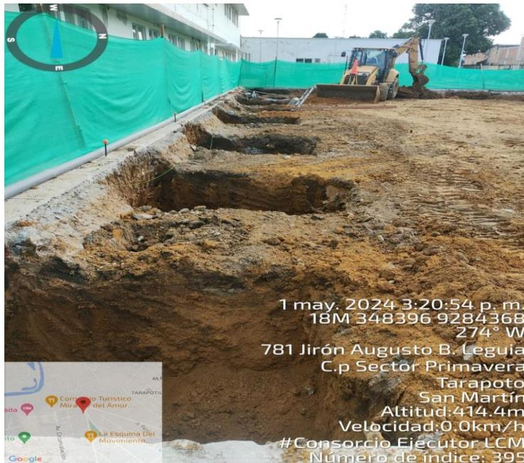
**Fotografía N° 02: EXCAVACION CON MAQUINARIA LAS ZANJAS DE ZAPATA**
