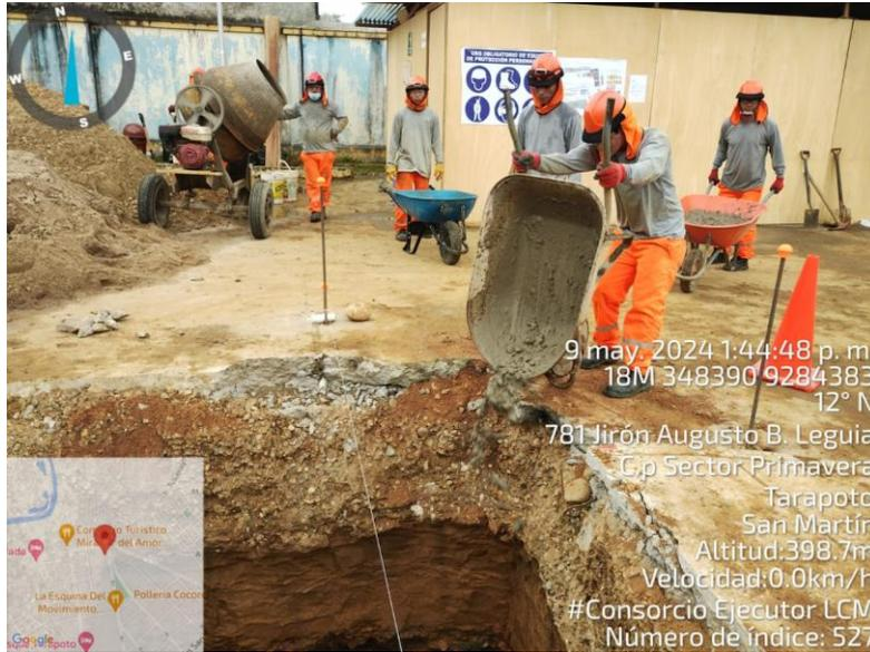
**Fotografía N° 09: VACIADO DE SOLADO EN ZAPATA**
