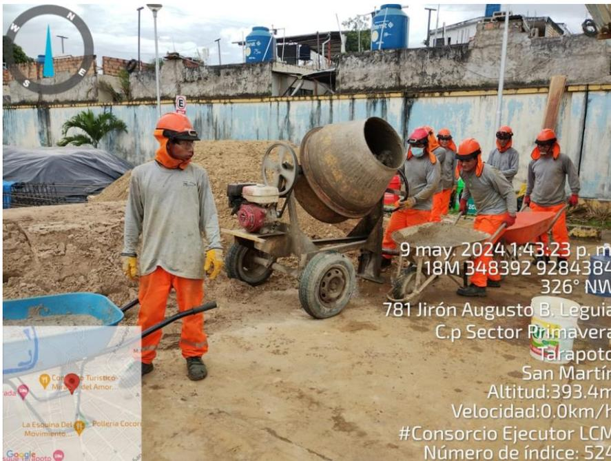
**Fotografía N° 08: TRASLADO DE SOLADO PARA ZAPATA**
