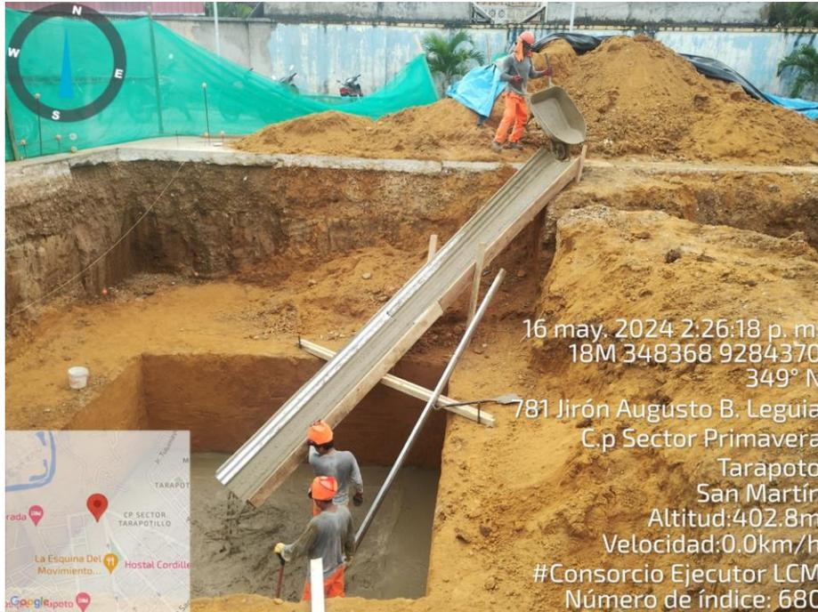
**Fotografía N° 19: VACIADO DE SOLADO EN CISTERNA**
