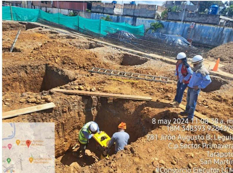
**Fotografía N° 04: COMPACTACION DE MATERIAL OVER EN ZAPATA**
