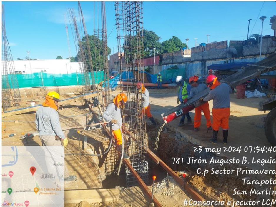
**Fotografía N° 26: VACIADO DE CONCRETO EN ZAPATA**
