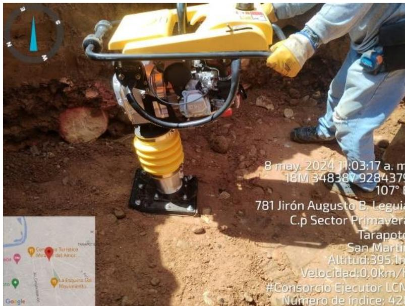
**Fotografía N° 02: COMPACTACION DE MATERIAL OVER EN ZAPATA**
