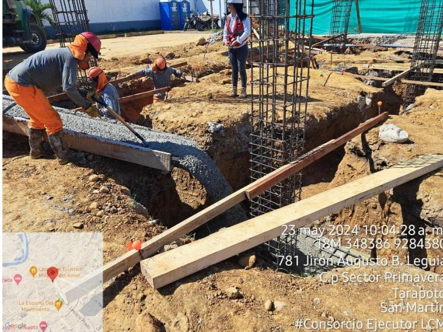
**Fotografía N° 27: VACIADO DE CONCRETO EN ZAPATA**
