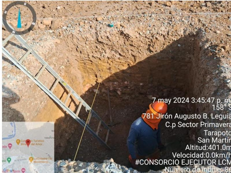
**Fotografía N° 01: EXCAVACION DE ZANJA DE ZAPATA**
