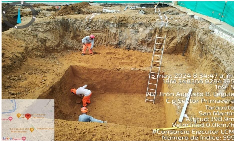
**Fotografía N° 16: PERFILADO DE CISTERNA**
