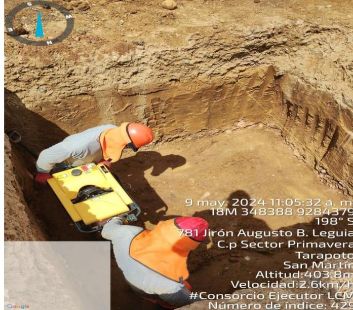
**Fotografía N° 05: COMPACTACION DE MATERIAL OVER EN ZAPATA**
