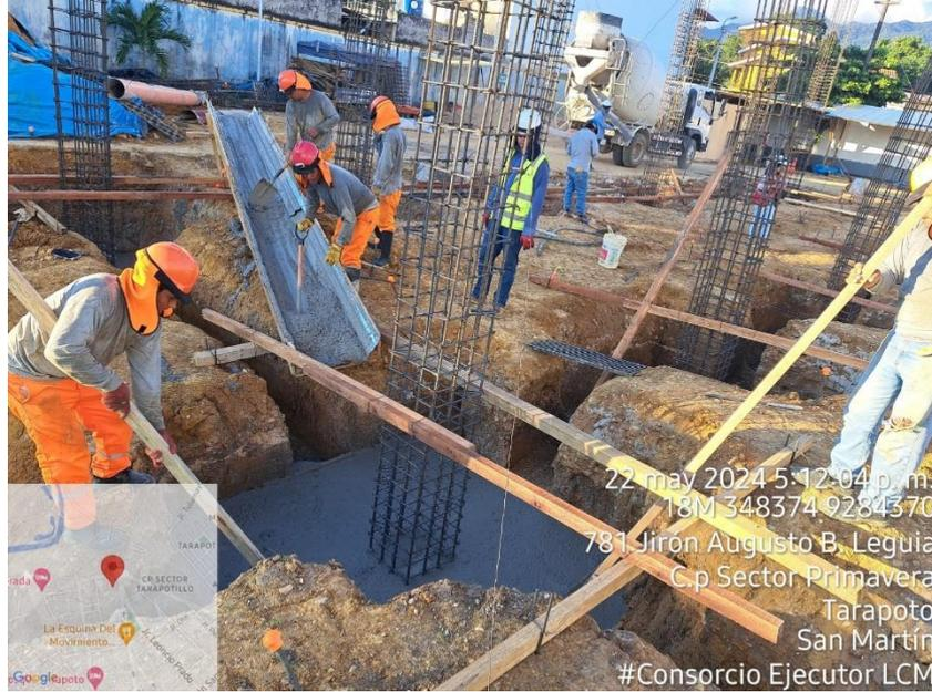
**Fotografía N° 25: VACIADO DE CONCRETO EN ZAPATA**
