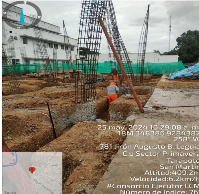
**Fotografía N° 30: EXCAVACION DE VIGAS DE CIMENTACION**
