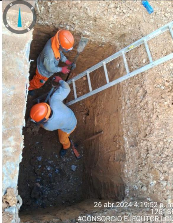
**Fotografía N° 14: PERFILADO DE ZANJA EN ZAPATA**
