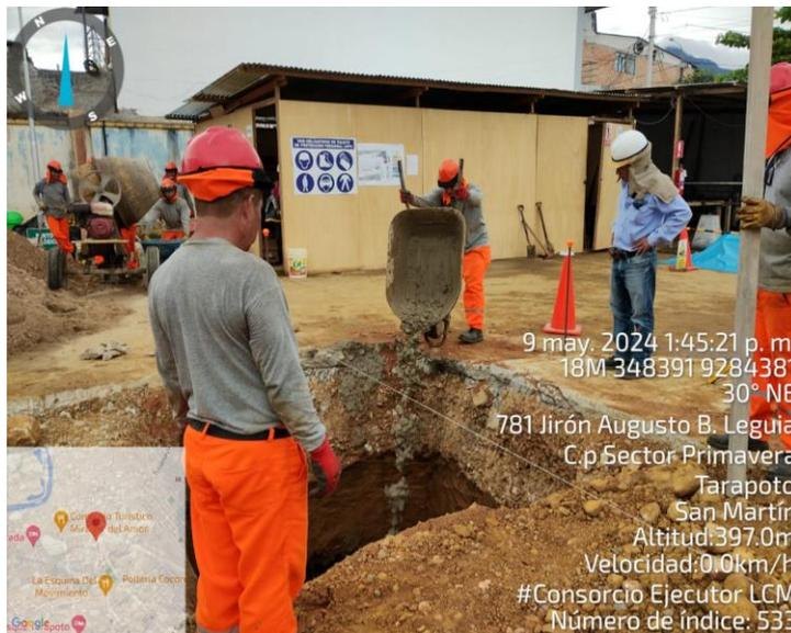
**Fotografía N° 06: VACIADO DE SOLADO EN ZAPATA**
