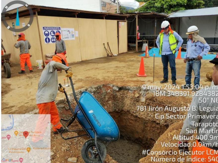
**Fotografía N° 07: VACIADO DE SOLADO EN ZAPATA**
