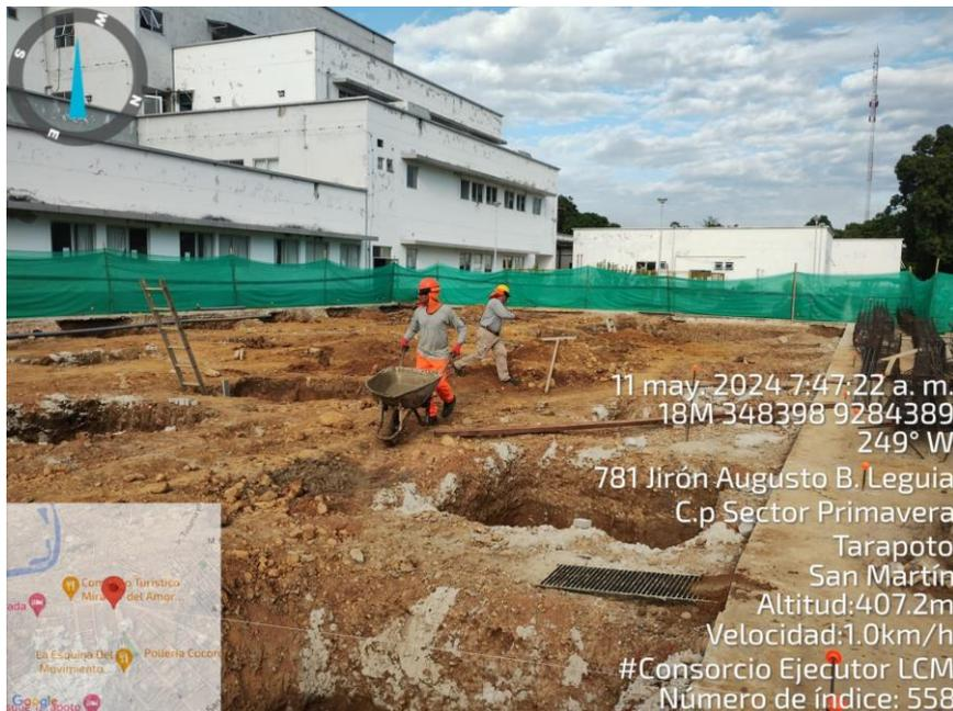
**Fotografía N° 10: TRASLADO DE SOLADO PARA ZAPATA**
