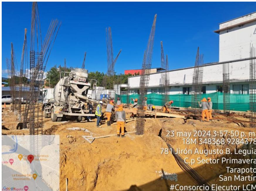
**Fotografía N° 28: VACIADO DE CONCRETO EN ZAPATA**
