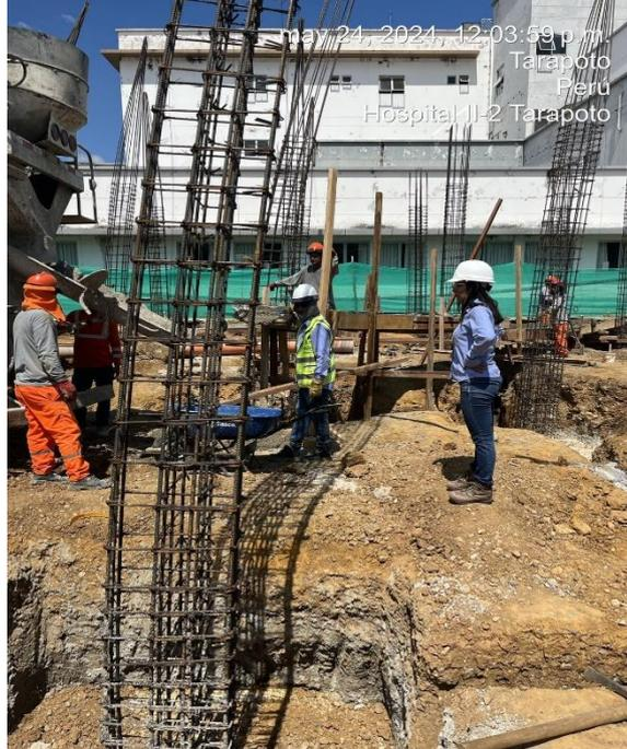
**Fotografía N° 29: VACIADO DE CONCRETO EN ZAPATA**
