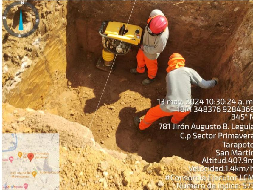
**Fotografía N° 15: COMPACTACION DE MATERIAL OVER EN ZAPATA**
