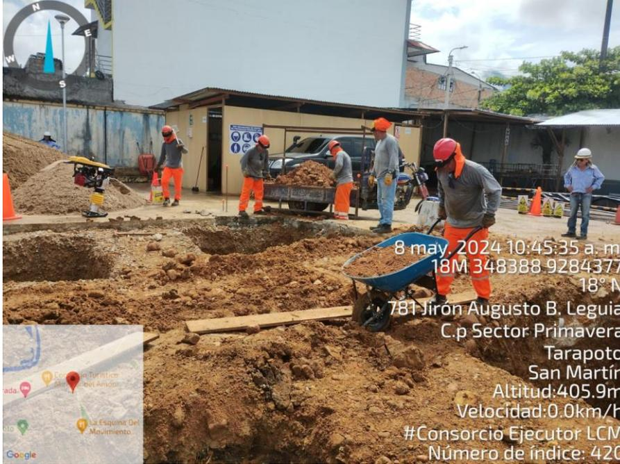
**Fotografía N° 03: TRASLADO DE MATERIAL OVER A ZAPATA**
