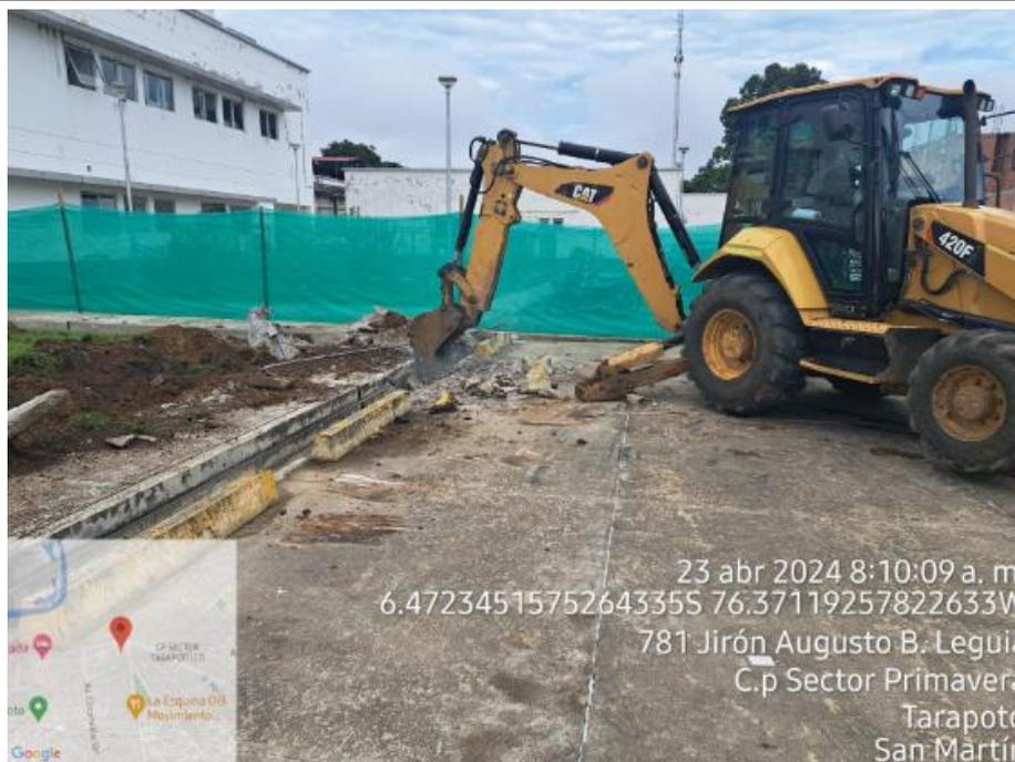
**Fotografía N° 02: DEMOLICION DE ESTRUCTURAS EXISTENTES**
