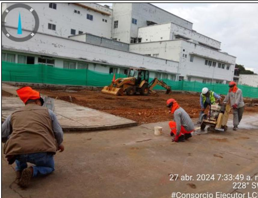
**Fotografía N° 13: CORTE EN CONCRETO – ESTRUCTURA EXISTENTE**
