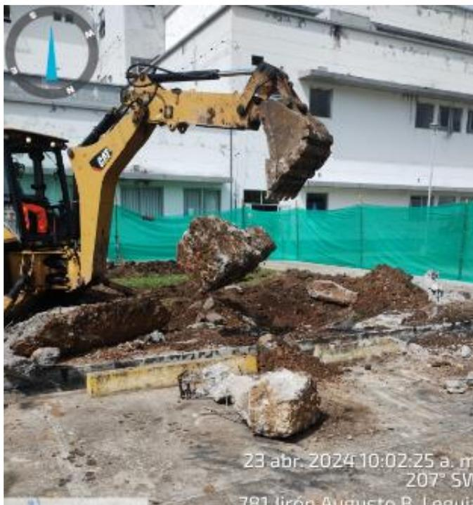
**Fotografía N° 03: DEMOLICION DE ESTRUCTURAS EXISTENTES**
