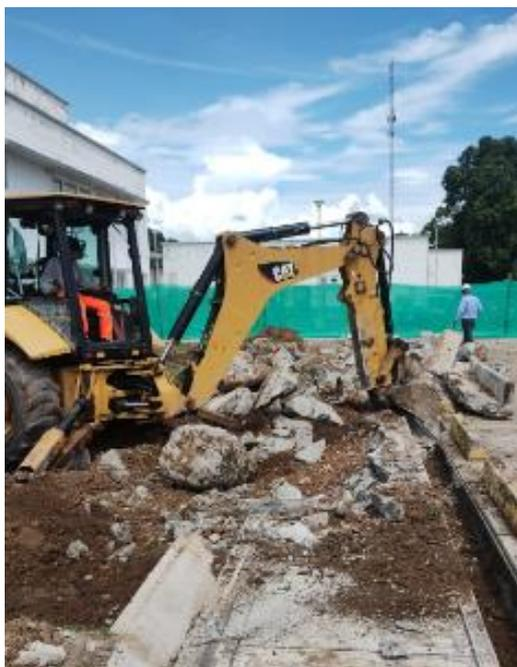
**Fotografía N° 05: DEMOLICION DE ESTRUCTURAS EXISTENTES**
