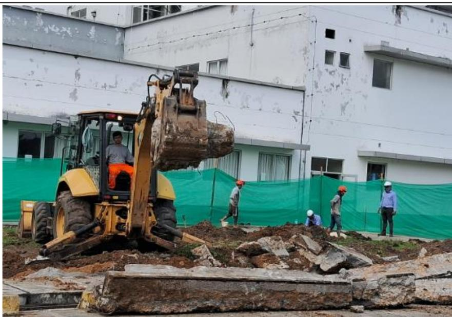
**Fotografía N° 04: DEMOLICION DE ESTRUCTURAS EXISTENTES**
