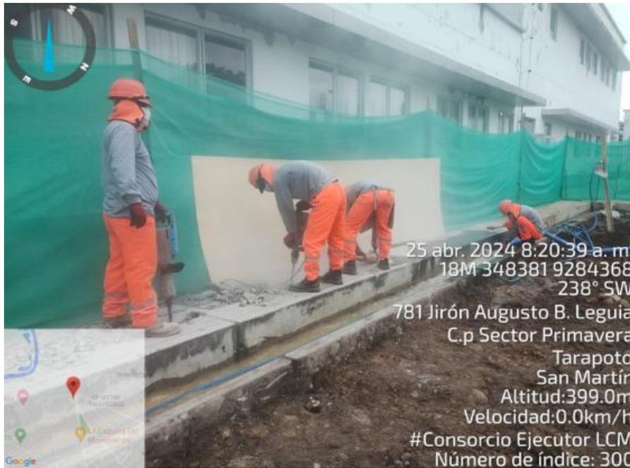
**Fotografía N° 07: CORTE EN CONCRETO – ESTRUCTURA EXISTENTE**
