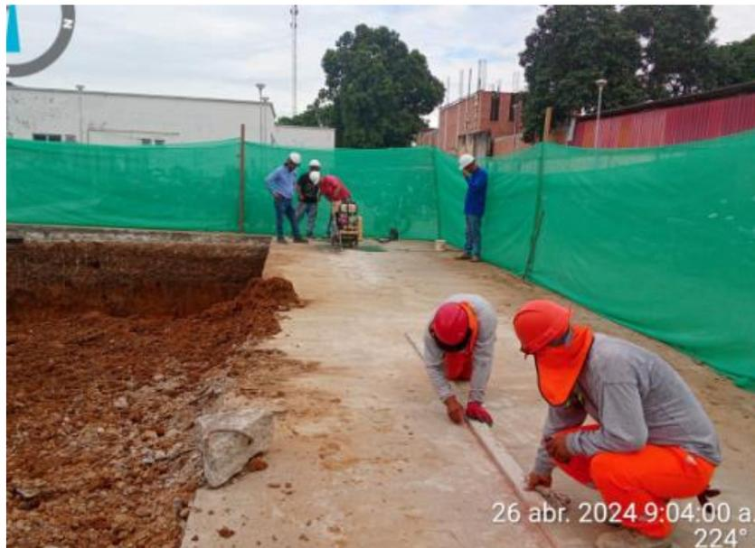
**Fotografía N° 08: CORTE EN CONCRETO – ESTRUCTURA EXISTENTE**
