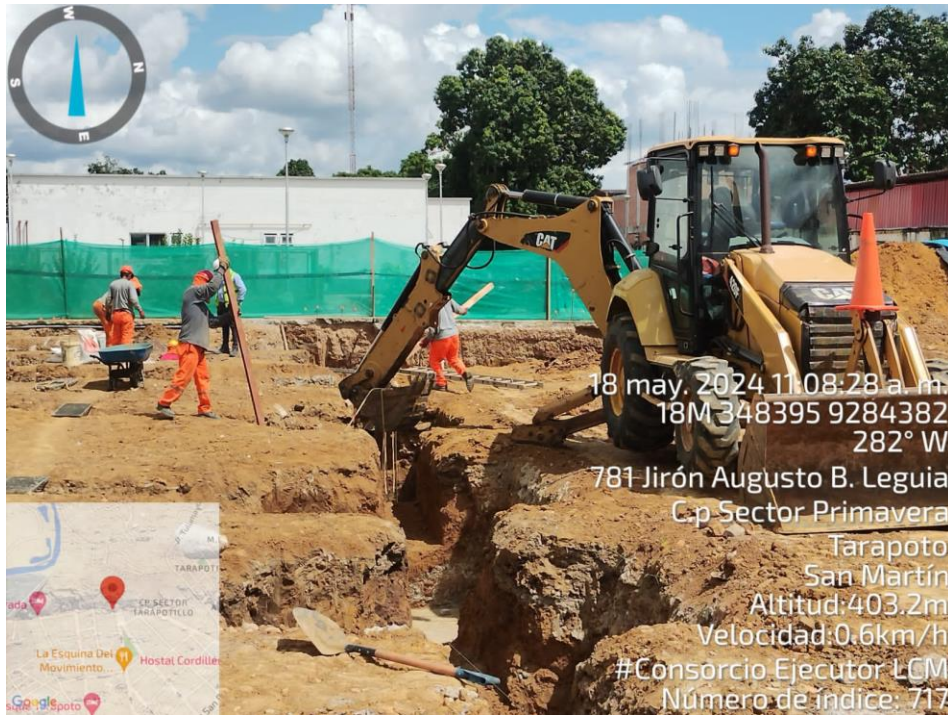
Fotografía N° 13: EXCAVACION CON MAQUINARIA LAS VIGAS DE CIMENTACION
