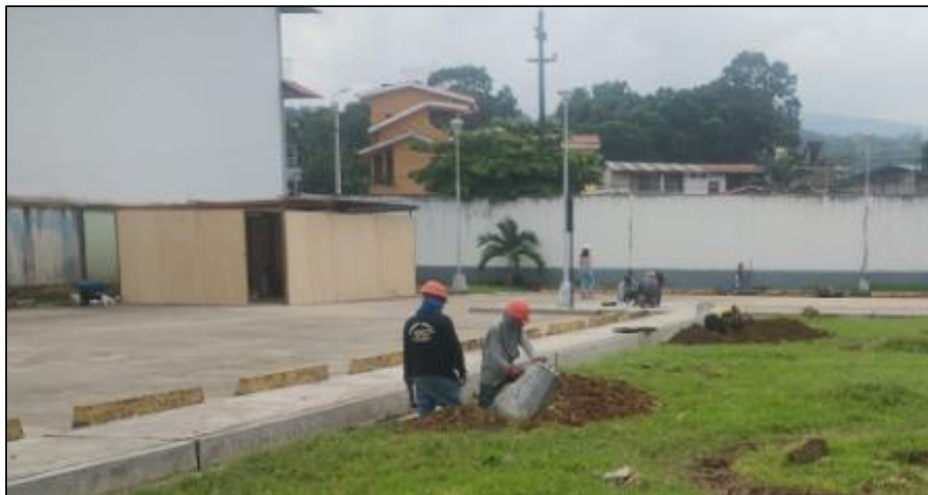
Fotografía N° 09: VISTA LATERAL DEL ALMACEN DE OBRA
