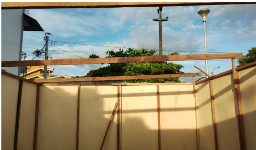
Fotografía N° 05: CONSTRUCCION DE ALMACEN DE OBRA
