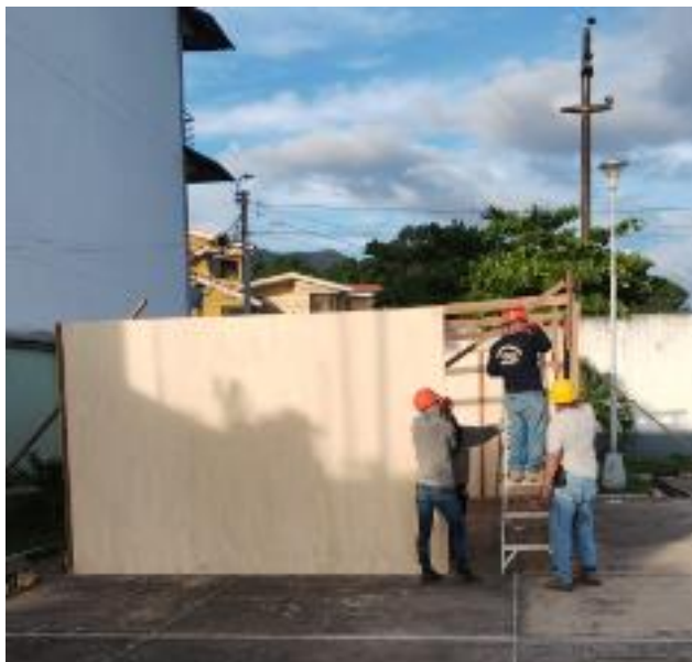
Fotografía N° 04: CONSTRUCCION DE ALMACEN DE OBRA
