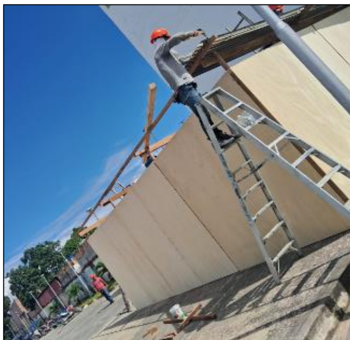
Fotografía N° 08: TECHADO EN ALMACEN DE OBRA
