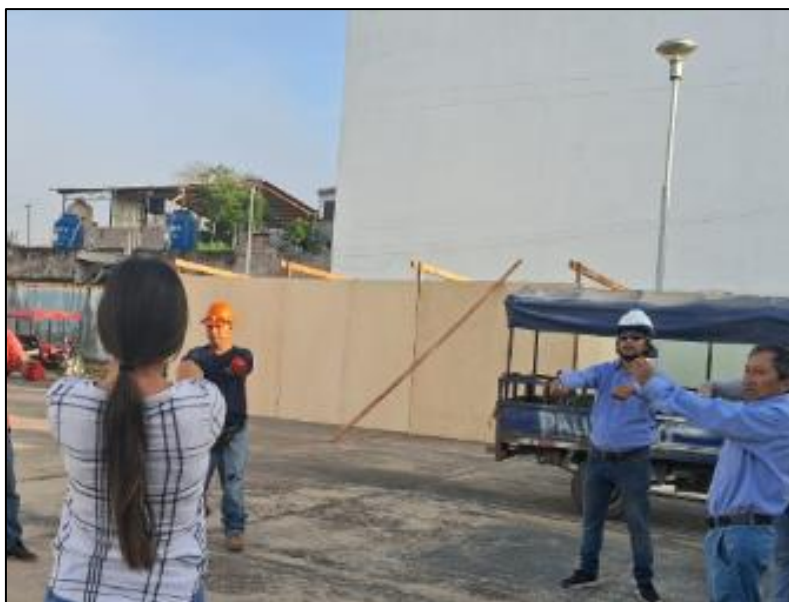
Fotografía N° 06: VISTA LATERAL DEL ALMACEN DE OBRA
