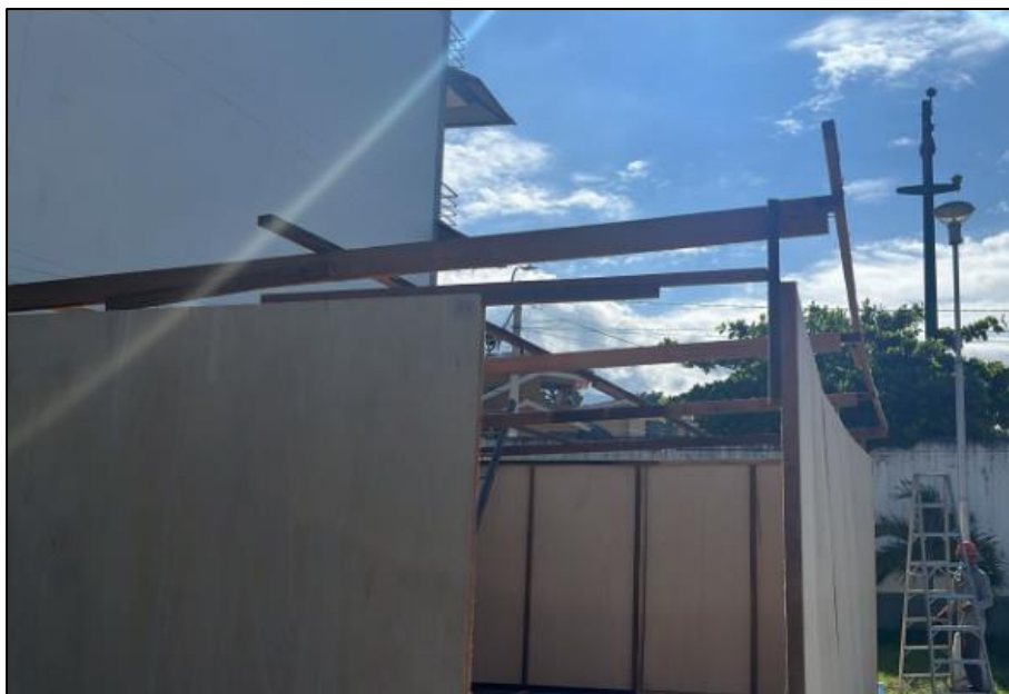
Fotografía N° 07: CONSTRUCCION DE ALMACEN DE OBRA
