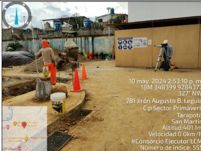
**Fotografía N° 06: NIVEL TOPOGRAFICO – EQUIPO TOPOGRAFICO**
