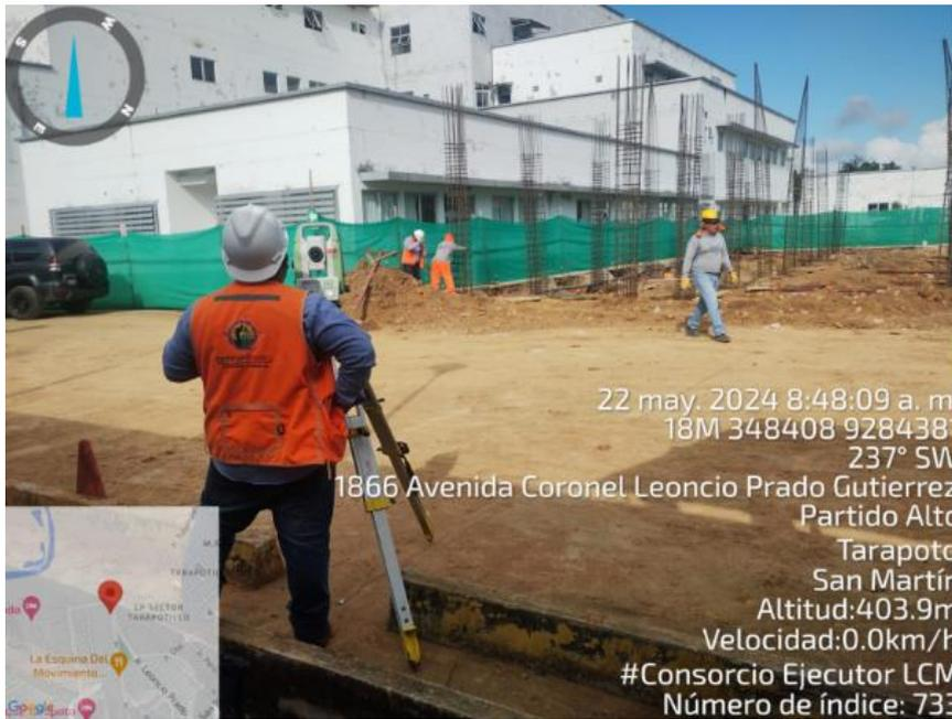
**Fotografía N° 05: ESTACIÓN TOTAL – EQUIPO TOPOGRAFICO**
