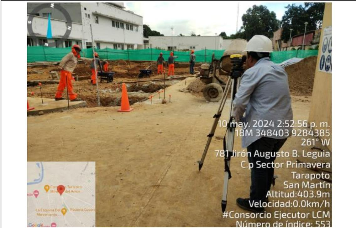
**Fotografía N° 03: NIVEL TOPOGRAFICO – EQUIPO TOPOGRAFICO**
