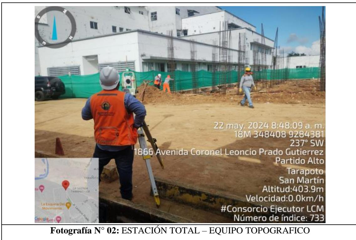
**Fotografía N° 02: ESTACIÓN TOTAL – EQUIPO TOPOGRAFICO**
