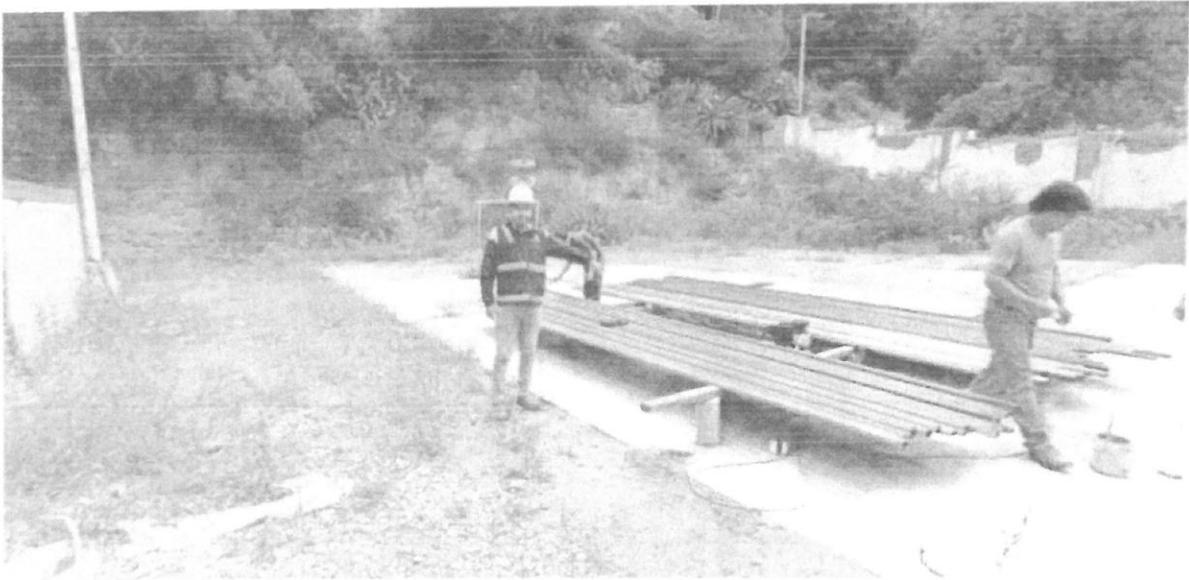
Foto N° 06.- Control en trabajos de pintado en estructuras metálicas para cobertura
