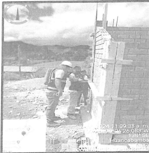
03. VERIFICACION DE ENCOFRADOS DE COLUMNETA PARA PROSEGUIR CON EL LLENADO.
