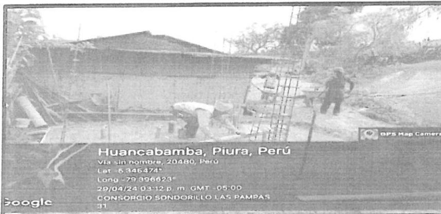
02. MONITOREO Y VERIFICACION DE LAS INSTALACIONES SANITARIAS Y VACEADO DE CONCRETO EN LOSA DE CIMENTACION.
