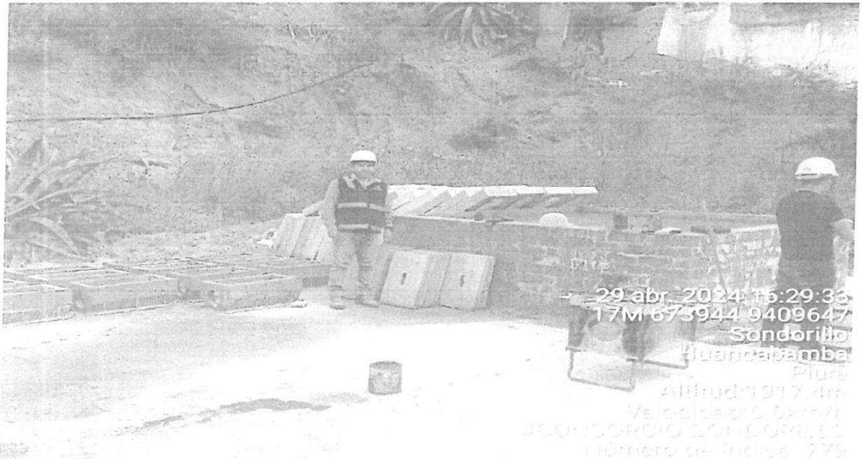
Foto N°03.- Poza de curado de cajas de agua y desagüe
