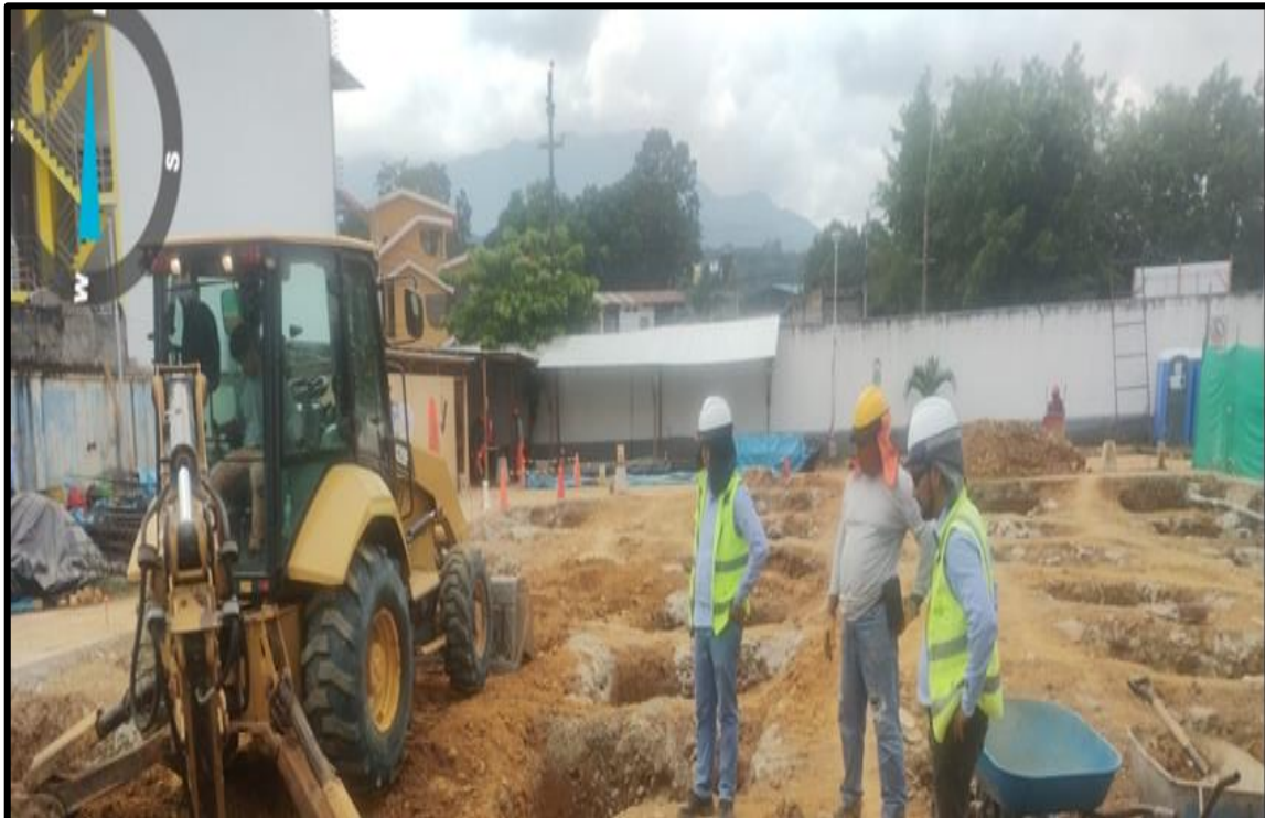
FOTO 02: EXCAVACION DE ZAPATAS
