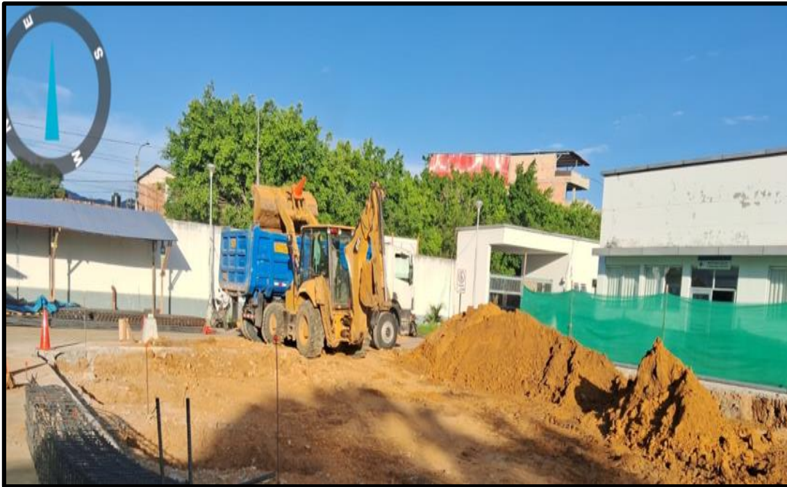
FOTO 01: ELIMINACION DE DESMONTE
