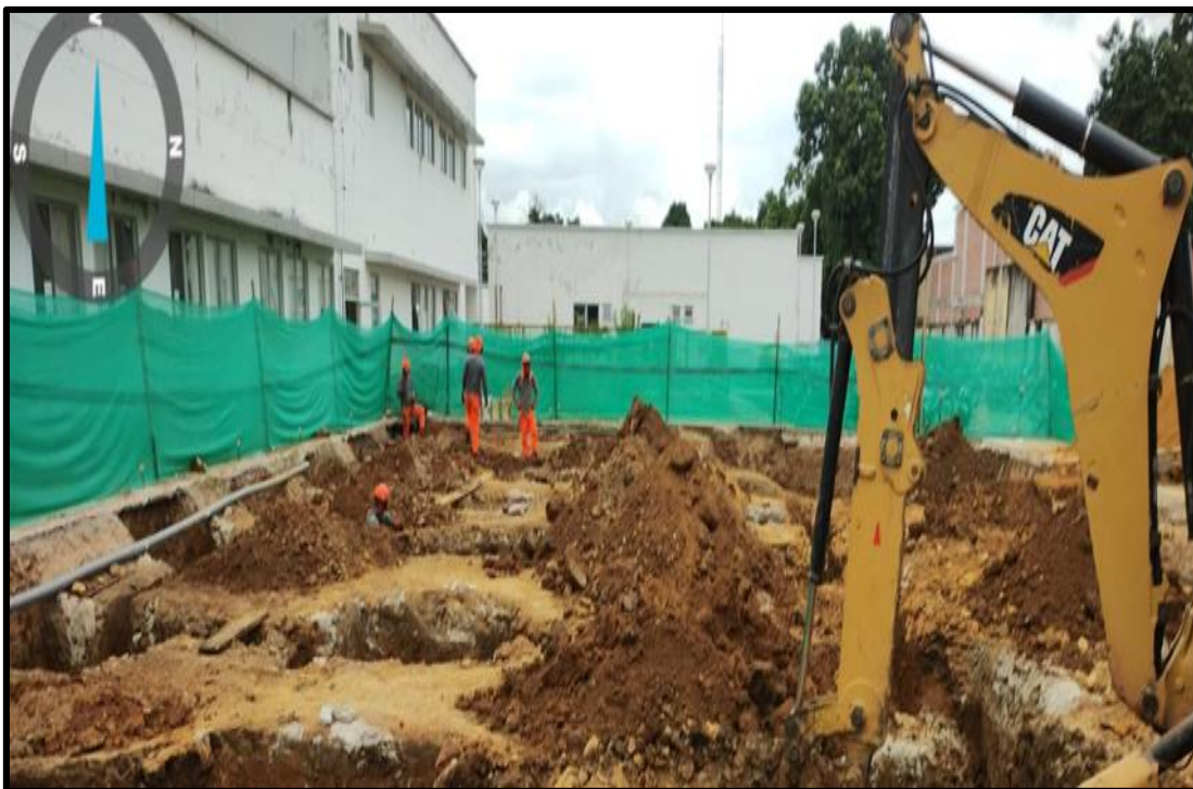
FOTO 04: EXCAVACION DE ZAPATAS
