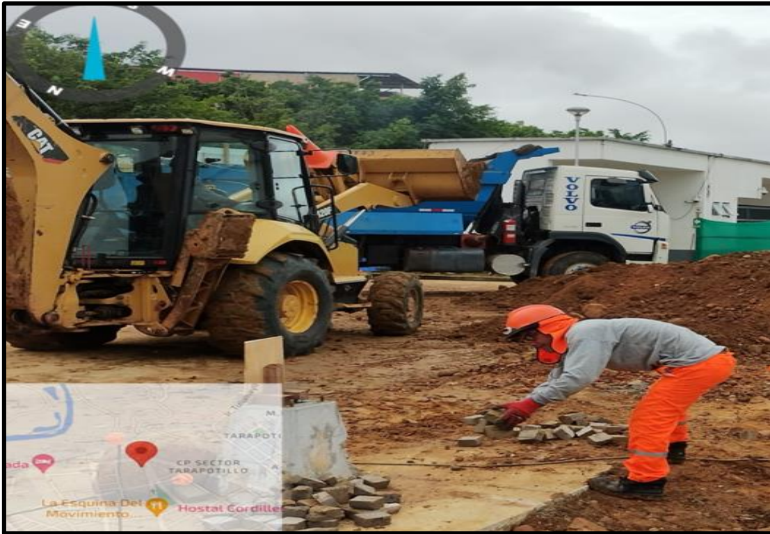
FOTO 05: ELIMINACION DE DESMONTE
