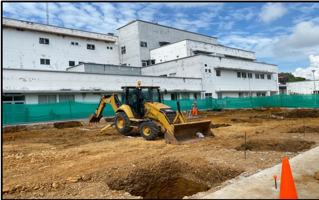
FOTO 03: EXCAVACION DE ZAPATAS
