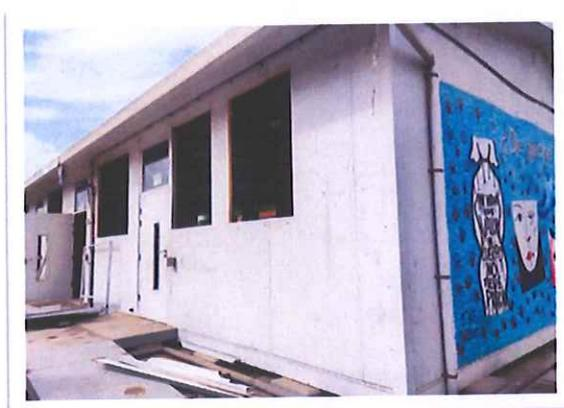
Figura 9. Desmontaje de ventanas existentes
