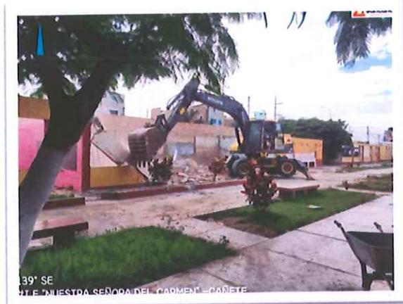
Figura 7. Demolición de cimientos existentes
