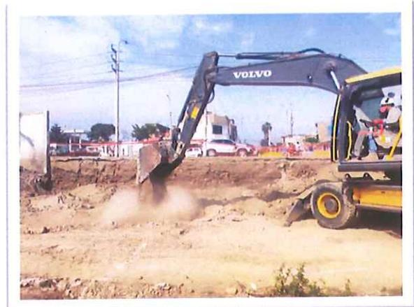
Figura 11. Excavación de zanja para vigas de Cimentación
