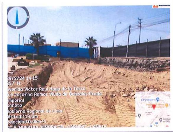
Figura 10. Excavación de zanjas para zapata
