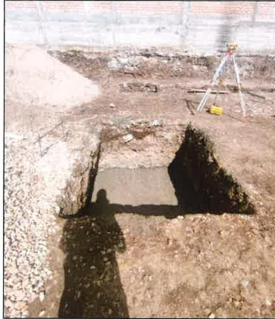
**Ilustración 03:** Se observa el vaciado de la falsa zapata en la obra principal, previa verificación del nivel del vaciado.
