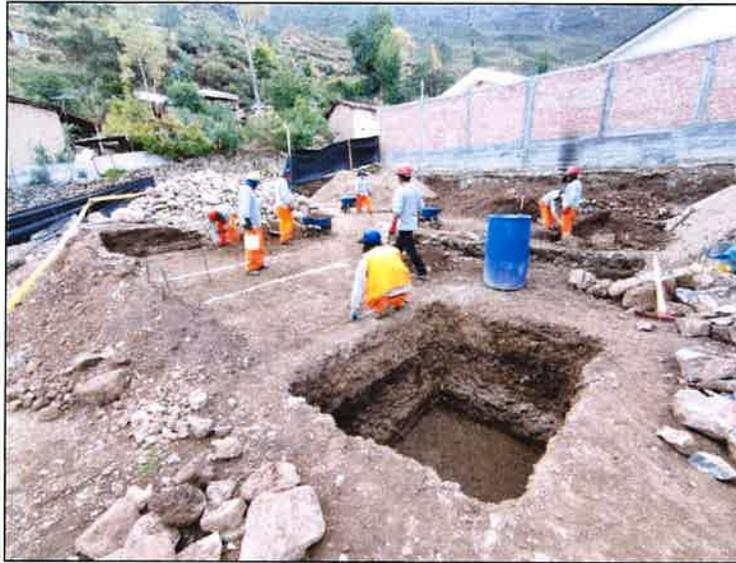
**Ilustración 01:** Se observa realizando el control del nivel para la excavación de zapatas en la obra principal.
