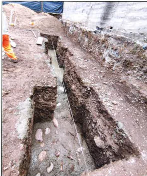
**Ilustración 02:** Se observa el vaciado de la falsa zapata en la obra principal, previa verificación del nivel del vaciado.
