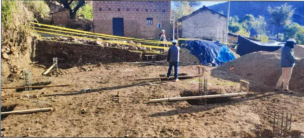
**Ilustración 06:** Se observa realizando el control del nivel terminado de la zapata para la excavación en el área en el área de contingencia
