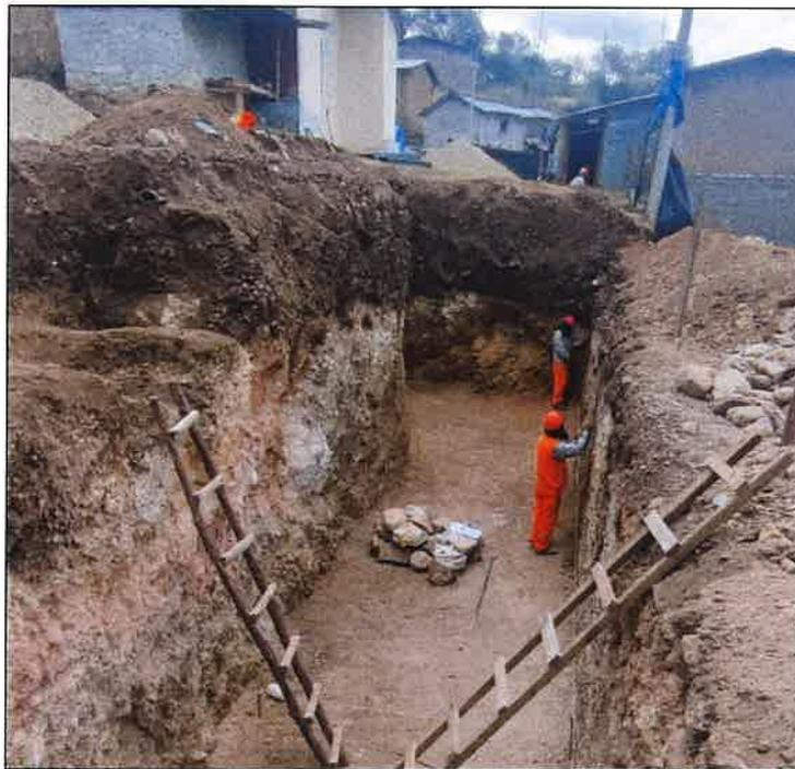
**Ilustración 07:** Se observa realizando el control del nivel de excavación para zapata de muro de contención del cerco perimétrico.
