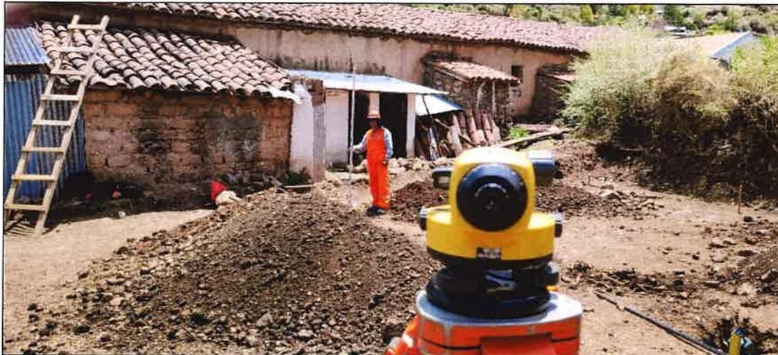
**Ilustración 04:** Se observa realizando el control del nivel terminado de la falsa zapata para la excavación en el área en el área de contingencia
