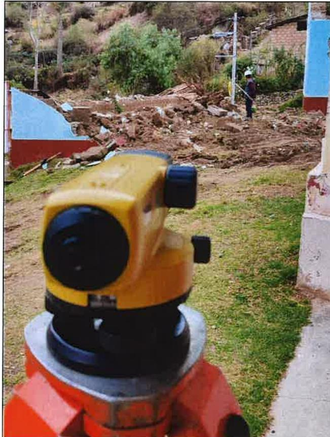
**Ilustración 01:** Se observa realizando el control del nivel de explanación en el área del proyecto principal.
