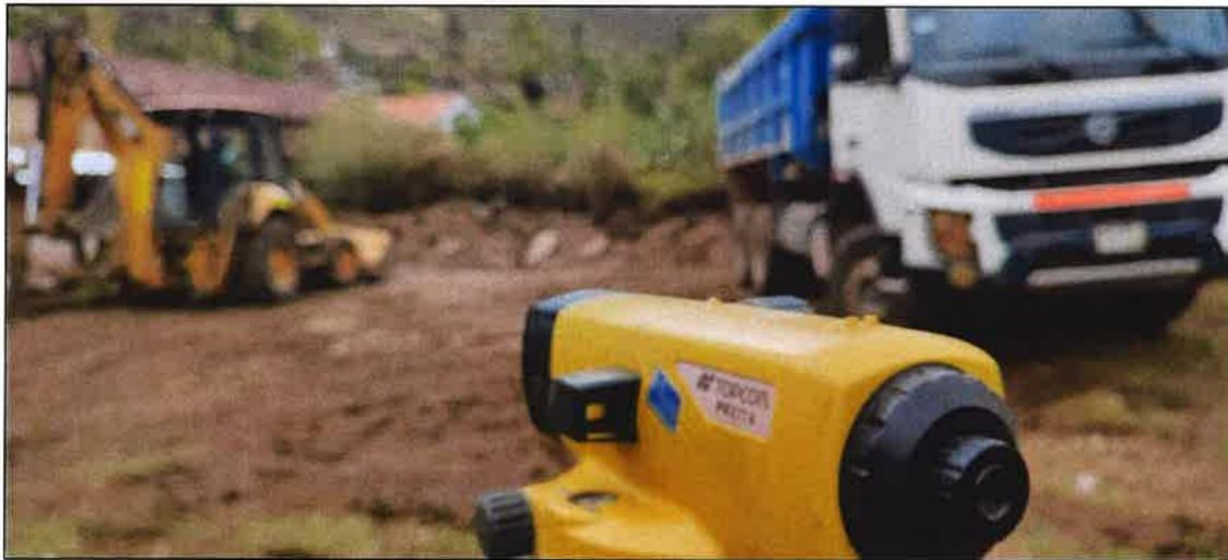
**Ilustración 03:** Se observa a la retroexcavadora realizando la explanación en el área de contingencia.
