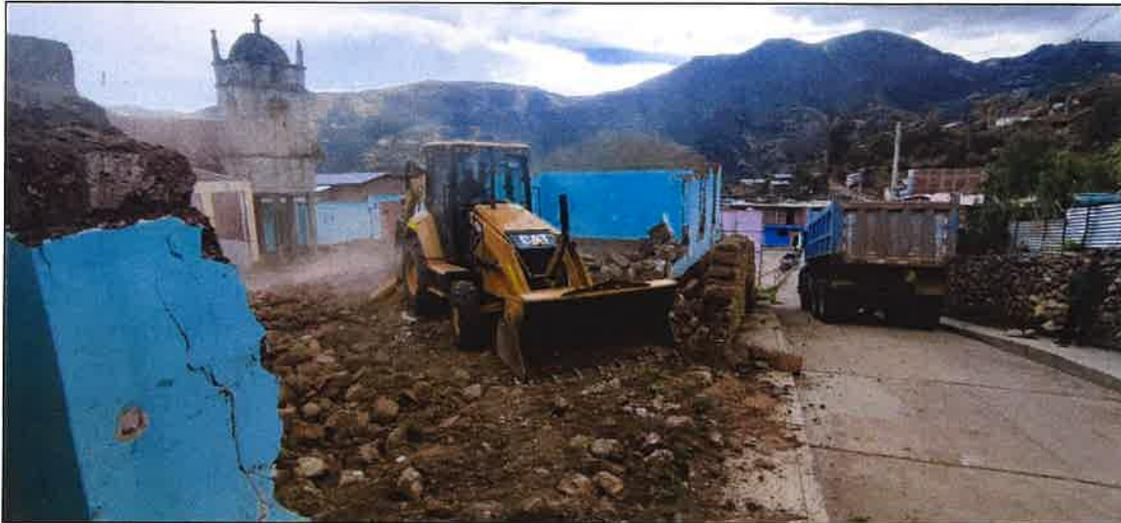
**Ilustración 02:** Se observa a la retroexcavadora realizando la explanación en el área del proyecto principal.
